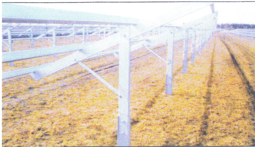
Verbindung Rammprofil mit Standrohr
