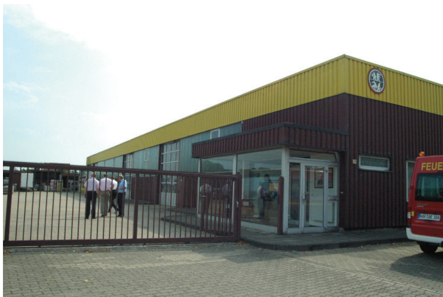
Abb. 7.22 Feuerwehrgerätehaus LZ Menninghausen
