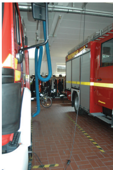
Abb. 7.29: Fahrzeughalle LZ Lette
