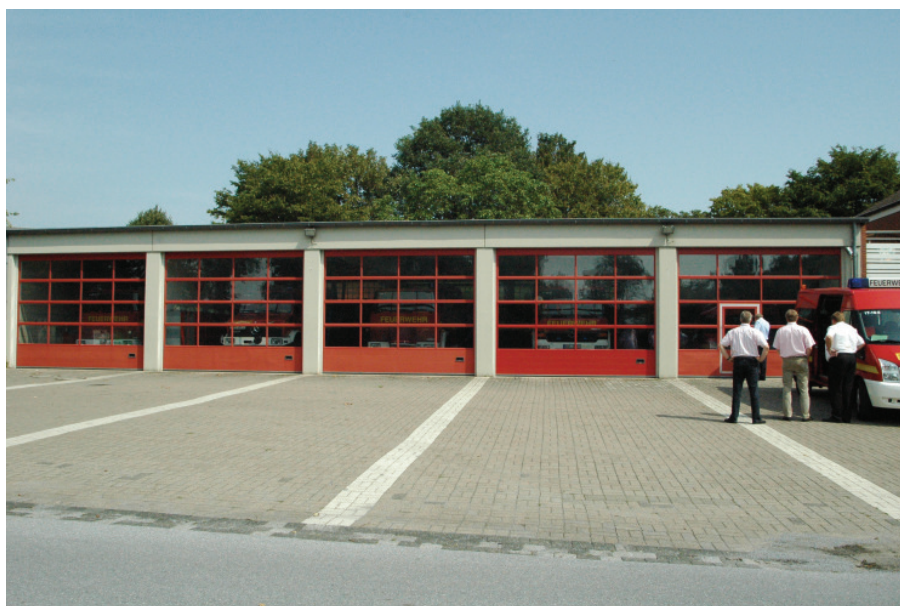
Abb. 7.25: Feuerwehrgerätehaus LZ Stromberg
