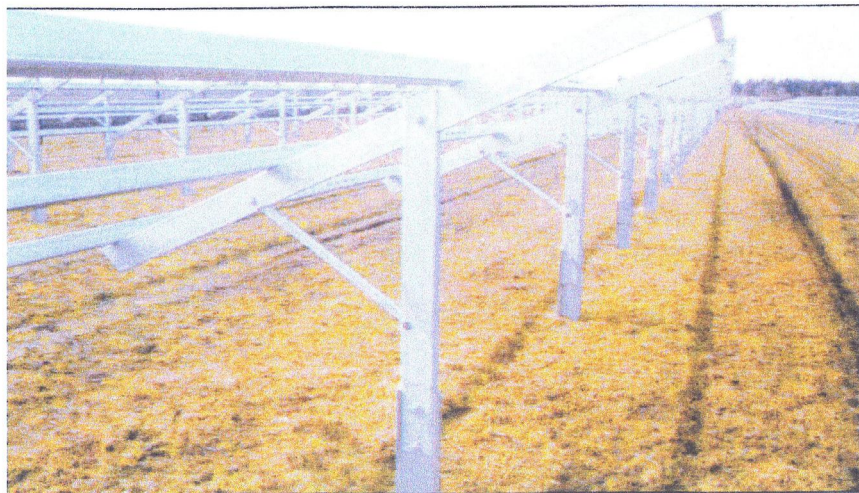
Verbindung Rammprofil mit Standrohr
