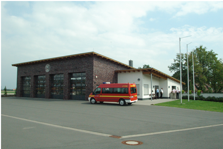
Abb. 7.30: Feuerwehrgerätehaus Keitlinghausen / Sünninghausen
