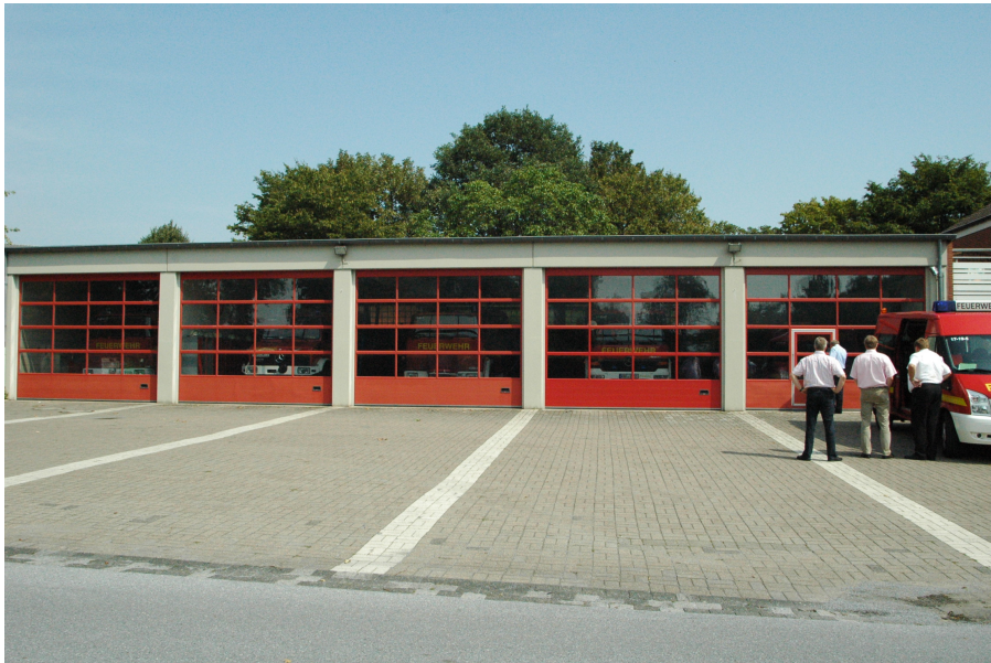
Abb. 7.25: Feuerwehrgerätehaus LZ Stromberg
