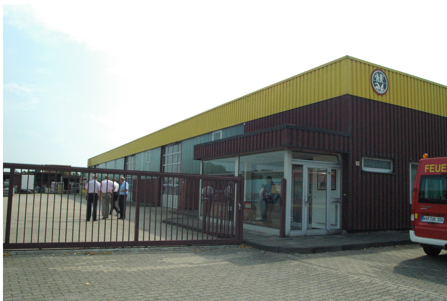
Abb. 7.22 Feuerwehrgerätehaus LZ Menninghausen
