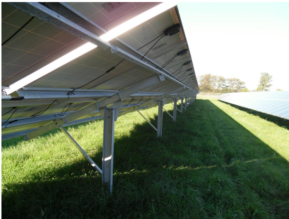
Beispielhaftes Foto der vorgesehenen Modultische (Quelle: Hilker Solar GmbH, Rahden in Westfalen, März 2013)
