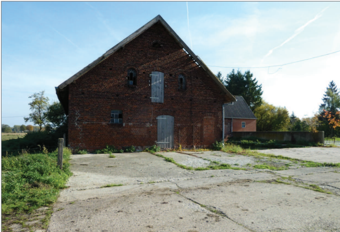
Abb. 7 Gebäude der ehemaligen Hofstelle Günnewig mit beginnenden Verfallserscheinungen
