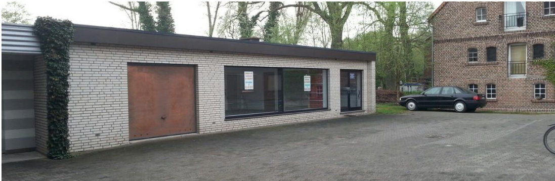
Dieses bislang noch leerstehende Gebäude könnte als Dorfzentrum für die Letter Bürger und Bürgerinnen genutzt werden.
