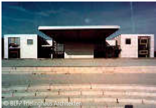
© BLF? Frielinghaus Architekten
