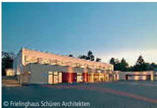
© Frielinghaus Schüren Architekten
