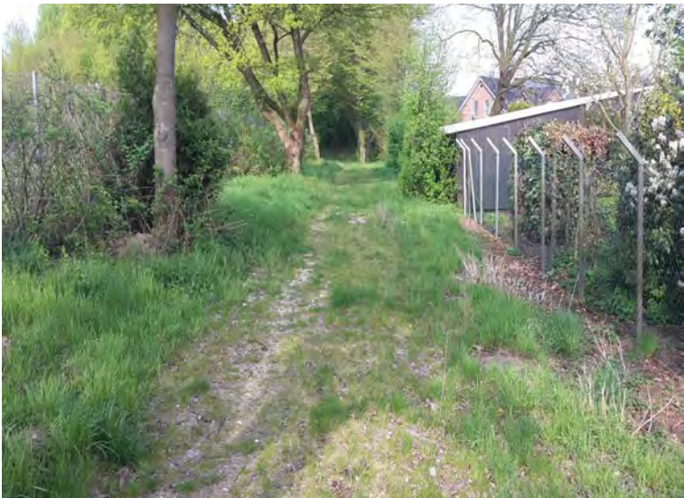
Verrohrter Bachverlauf Höhe Rote Erde
