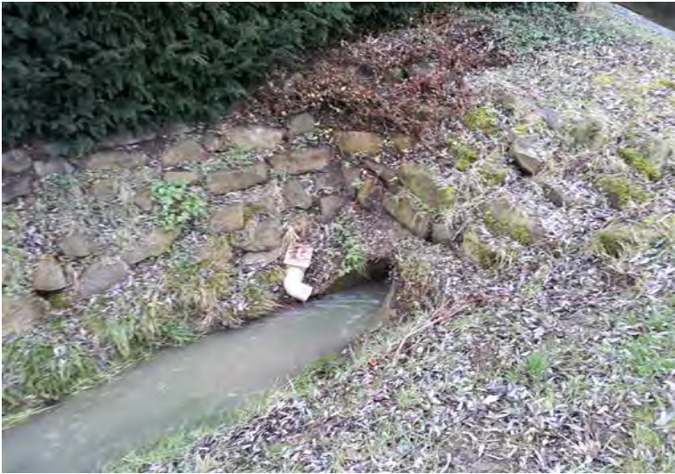
Verrohrung Carl- von-Ossietzky-Straße
