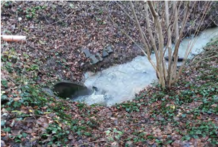
Verrohrung im Bereich „Am Landhagen“
