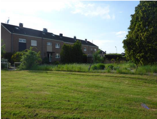
Abb. 9 Nördlich an das Plangebiet angrenzende Reihenhäuser.
