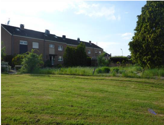
Abb. 7 Nördlich an das Plangebiet angrenzende Reihenhäuser.
