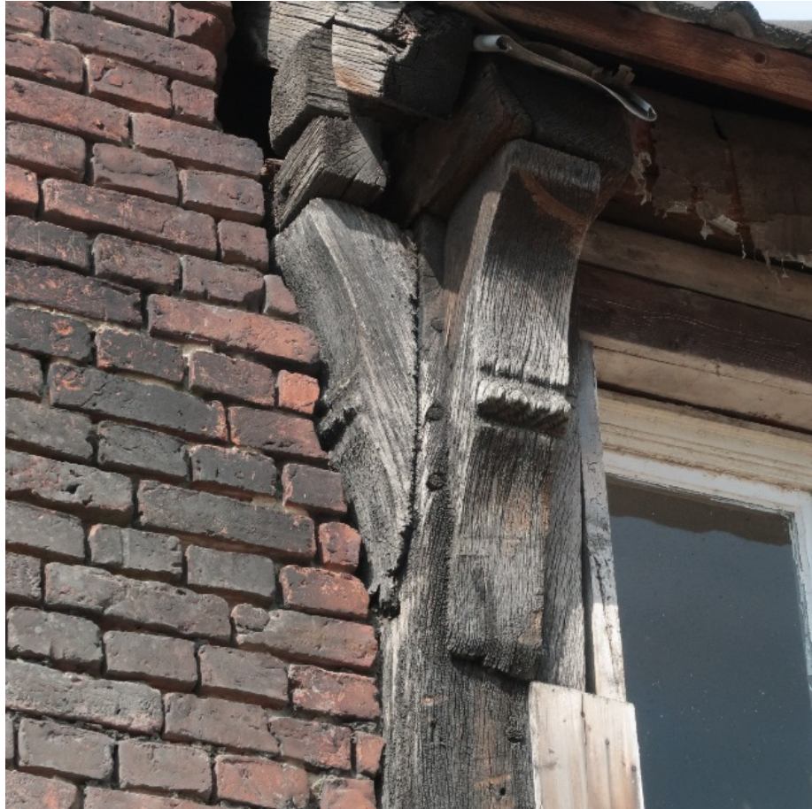
Südöstlicher Eckständer mit zweiseitiger Vorkragung, daran angeschlossen der Backsteinanbau (LWL-DLBW)
