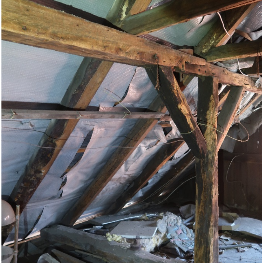
Dachkonstruktion mit Stehendem Stuhl (LWL-DLBW)
