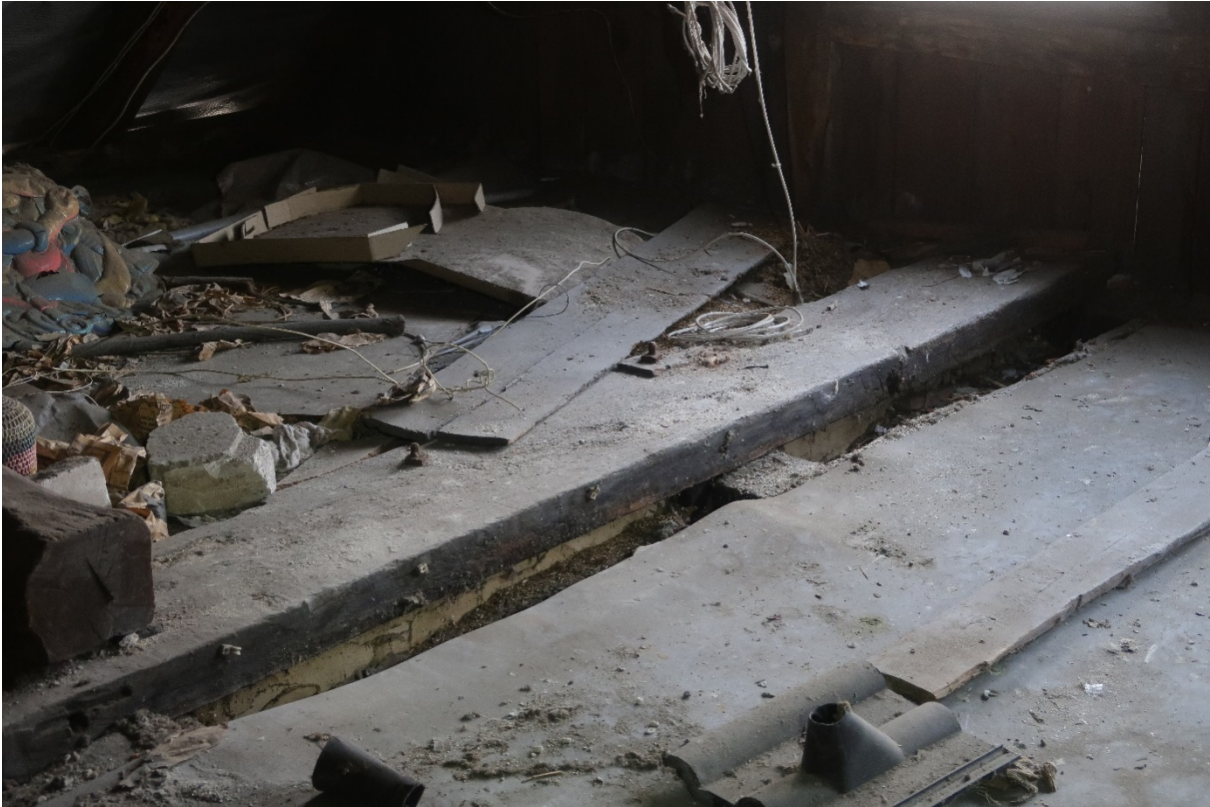
DG, Rähm der früheren Ostwand des Speikers, mit ursprünglichen Knotenpunkten und historischer Verschwärzung (LWL-DLBW)
