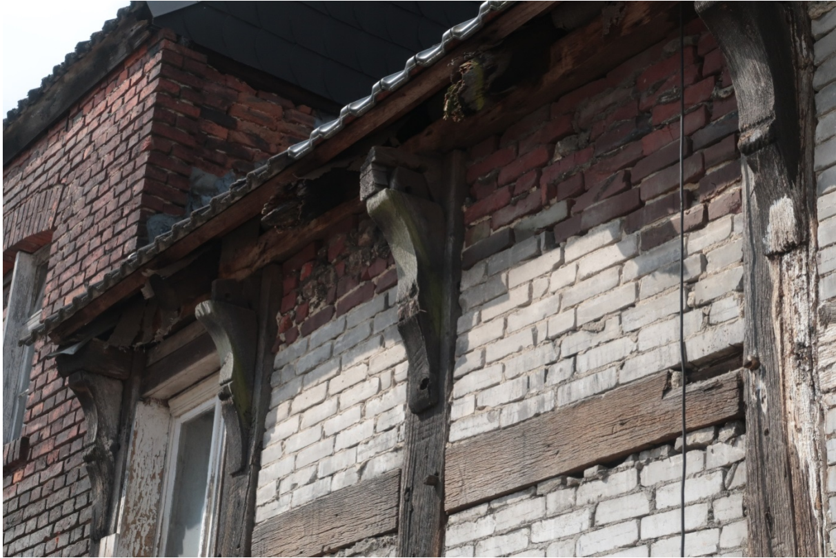
Ostfassade, Detail der Knaggen. Im Streiflicht sind die Abbundzeichen der Zimmerleute zu erkennen, auf den Knaggen sind die eingehälsten Dachbalken aufgezapft. (LWL-DLBW)
