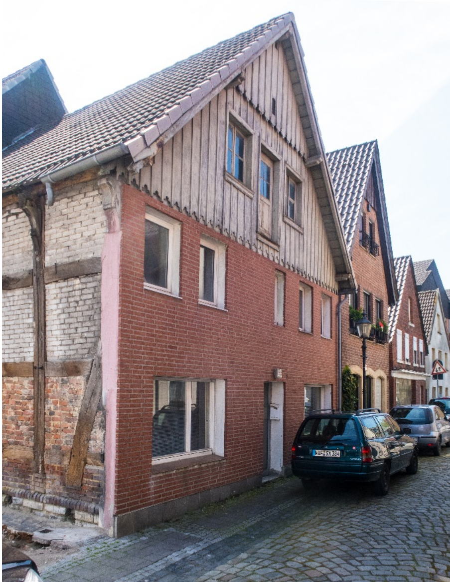
Straßenfassade mit Giebel des der 1880er Jahre und Klinkern der 1970er (LWL-DLBW)
