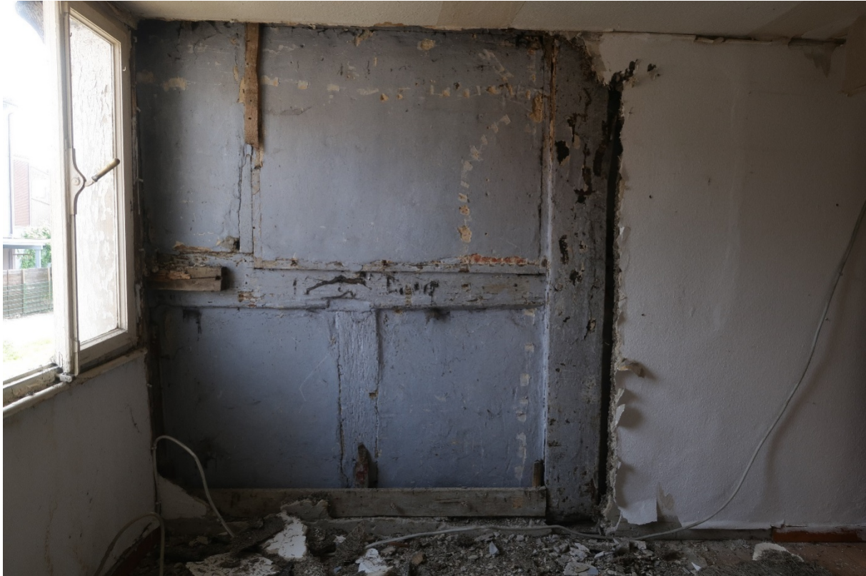
Obergeschoß, Südostrraum, Innenansicht der historischen Rückfassade, freigelegt unter der Verkleidung. Im oberen Gefach befand sich einmal ein Fenster, wie der zugemauerte Rahmen zeigt. (LWL-DLBW)
