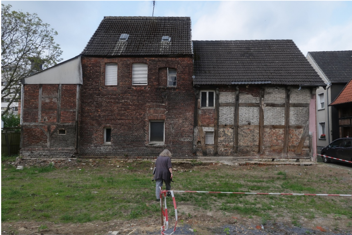
Ansicht von Osten. Deutlich zu unterscheiden sind das denkmalwerte Gebäude (rechts) und die späteren Anbauten. (LWL-DLBW)
