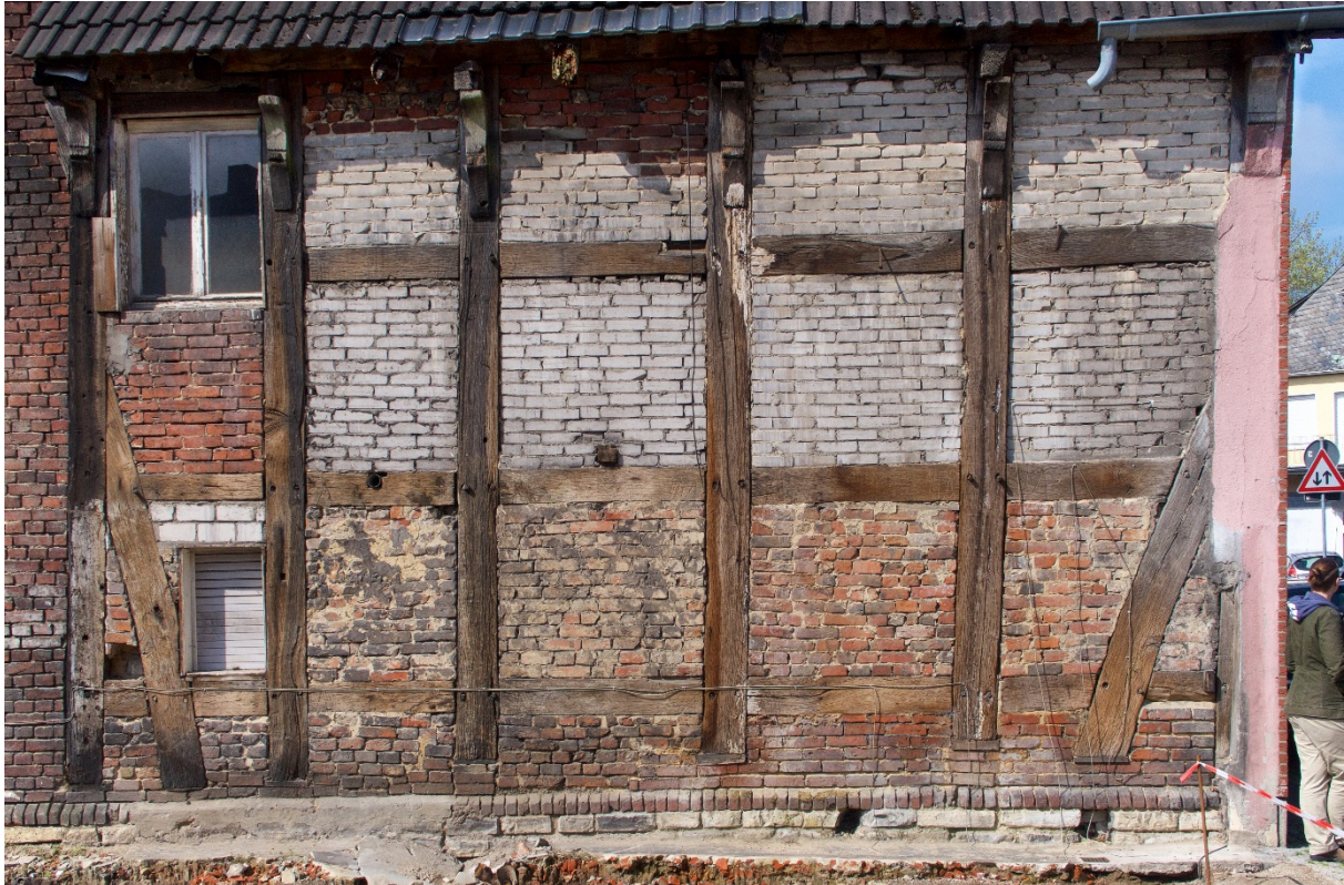
Entzerrte Ansicht der Ostfassade, die Ausfachungen stammen aus dem späten 19. Jahrhundert und dem 20. Jahrhundert (Kalksandstein). (LWL-DLBW)
