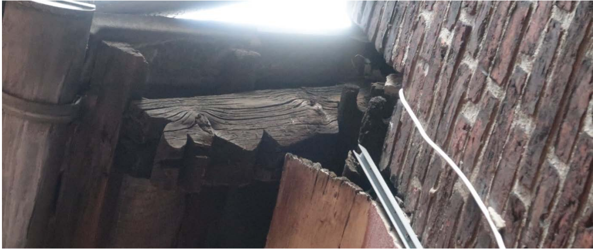
Westliche Traufe, profilierter Auschiebling der Umbauphase 1882. (LWL-DLBW)
