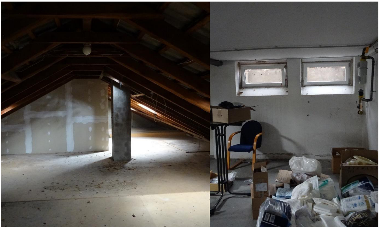
Abbildung 9: Dachboden und Keller der Caritas-Sozialstation.
