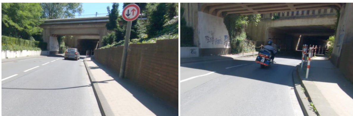
Abbildung 27: Oelde, Bahnunterführung, Werner-Habig-Straße
