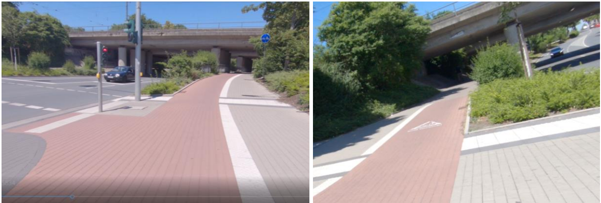
Abbildung 30: Oelde, Bahnunterführung, L793 Warendorfer Straße
