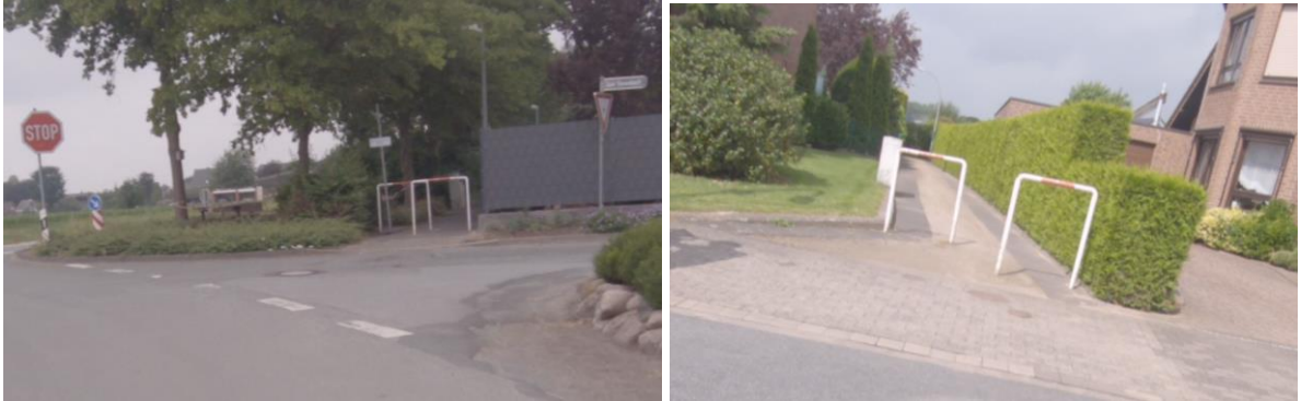
Abbildung 42: Sünninghausen, Umlaufsperrn, Auf der Höhe / Zum Tienenbach, Faulbaumstraße
