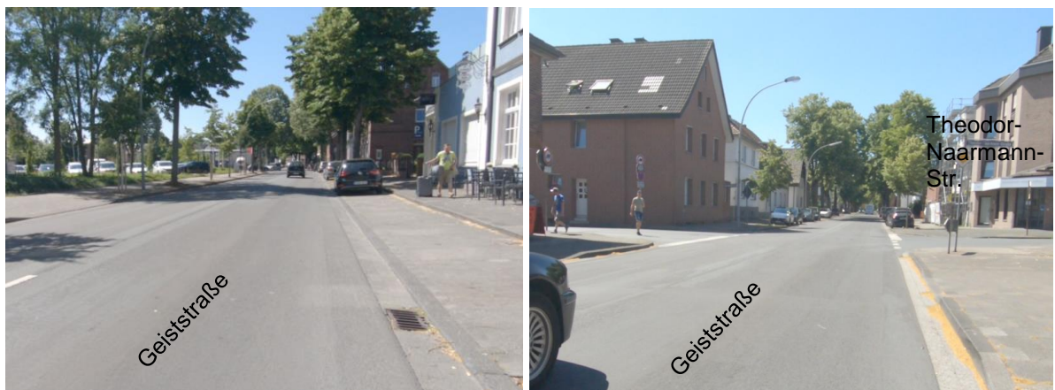
Abbildung 33: Oelde, L792 Geiststraße / Theodor-Naarmann-Straße, keine Radverkehrsführung vorhanden
