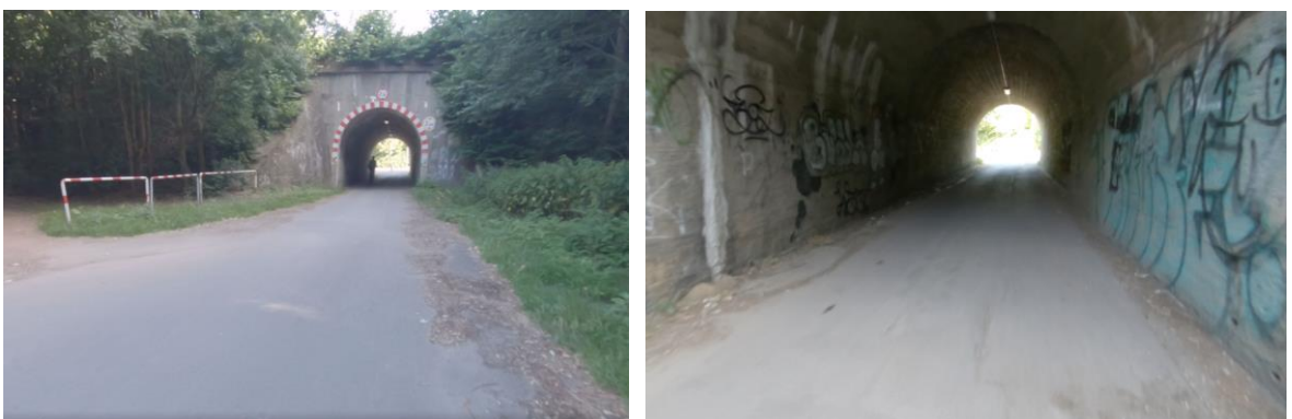
Abbildung 31: Oelde, Bahnunterführung, Wiedenbrücker Straße
