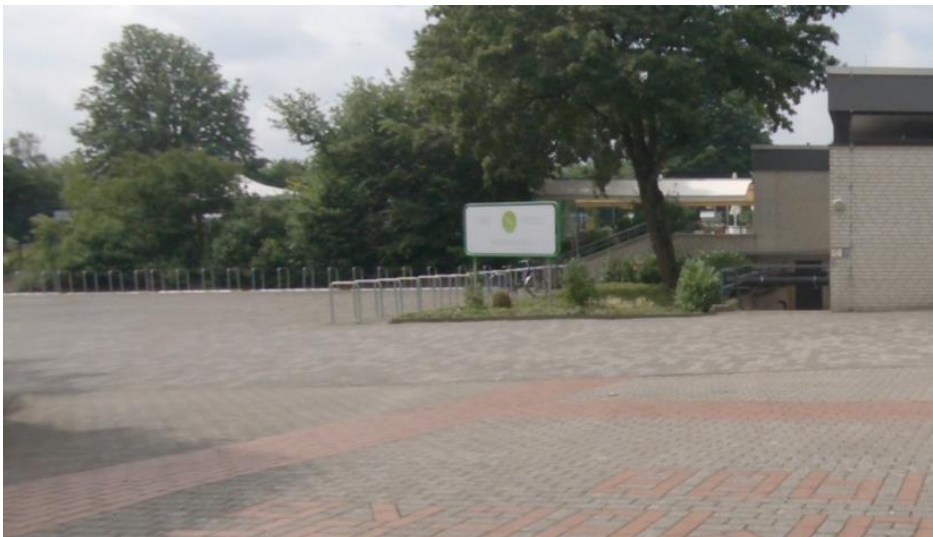
Abbildung 55: Fahrradabstellanlagen, Freibad Stromberg
