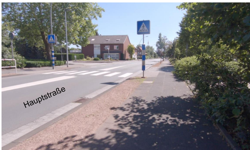
Abbildung 21: Lette, L 806 Hauptstraße, Radfahrer müssen bereits hier die Straße queren
