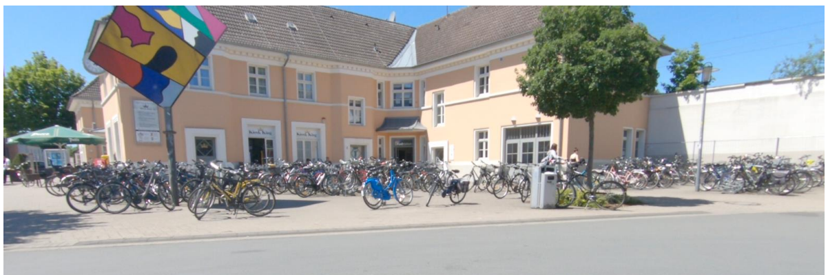
Abbildung 45: Fahrradabstellanlagen, Bahnhof Oelde
