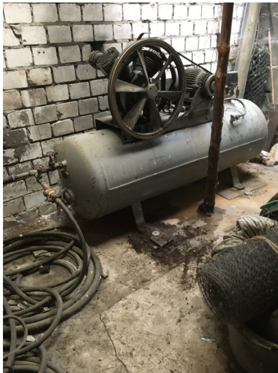
Foto: Kompressor, Sondierung RKS 5
