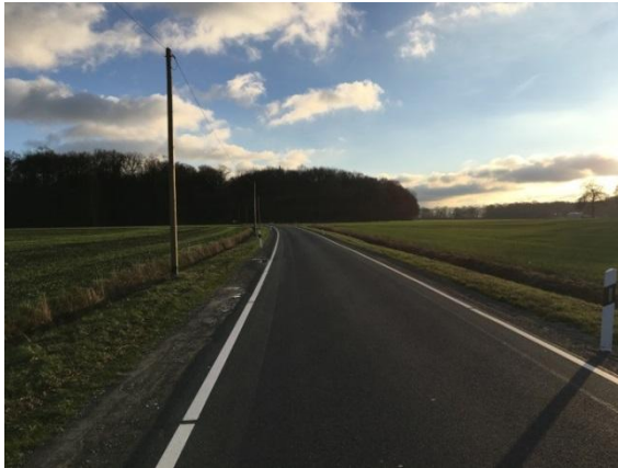
Abbildung 23: Freileitung, Telekommunikation, Oststraße, ca. 4+600
