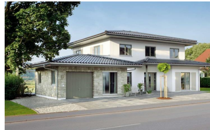
Einfamilien- haus mit Zeltdach
