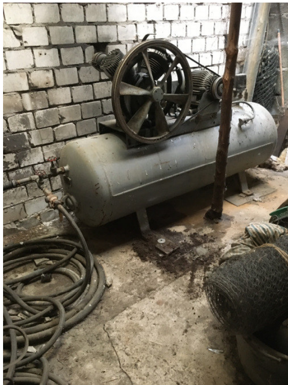
Foto: Kompressor, Sondierung RKS 5
