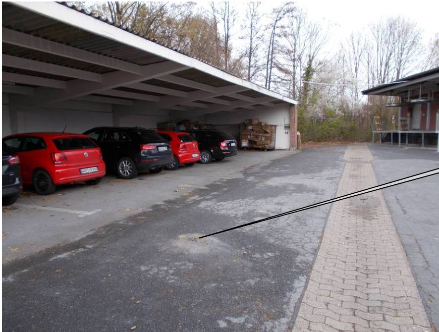
Foto 5: Blickrichtung ~ S; Bereich der BS 3 (Markierung)
