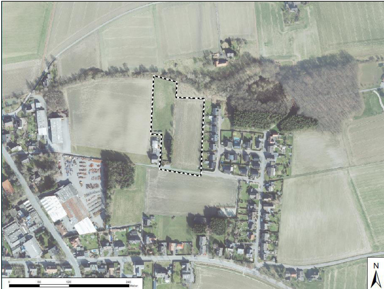
Abb. 1: Plangebiet „Am Tienenbach II“ - Luftbildübersicht
