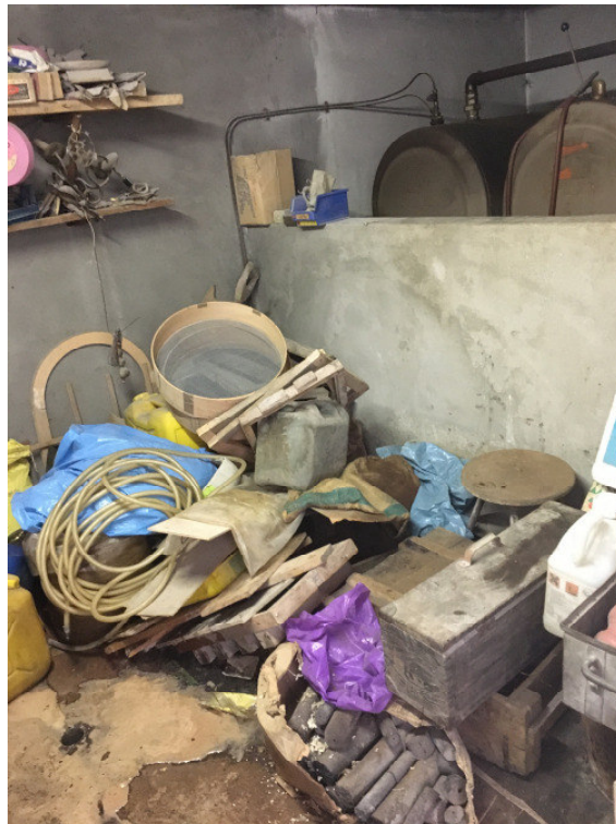
Foto: Heizungsraum, Sondierung RKS 6
