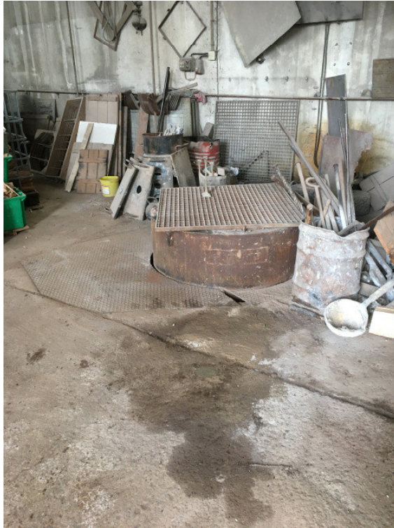
Foto: Grube mit Schmelztiegel und Ölbrenner, Sondierung RKS 4
