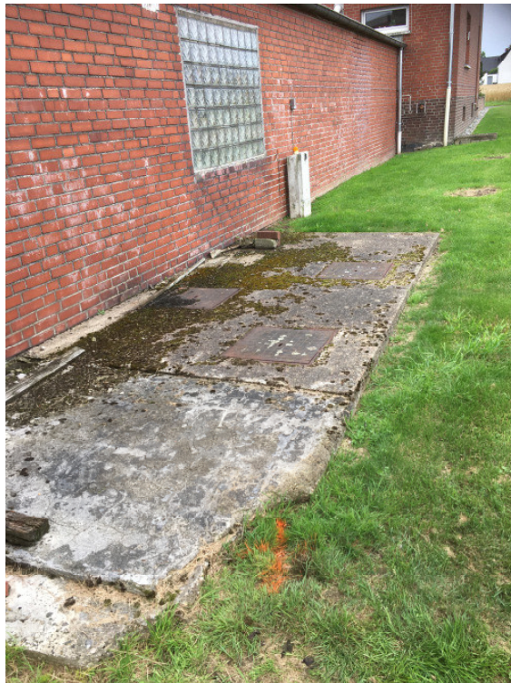
Foto: ehem. Klärgrube, Sondierung RKS 1
