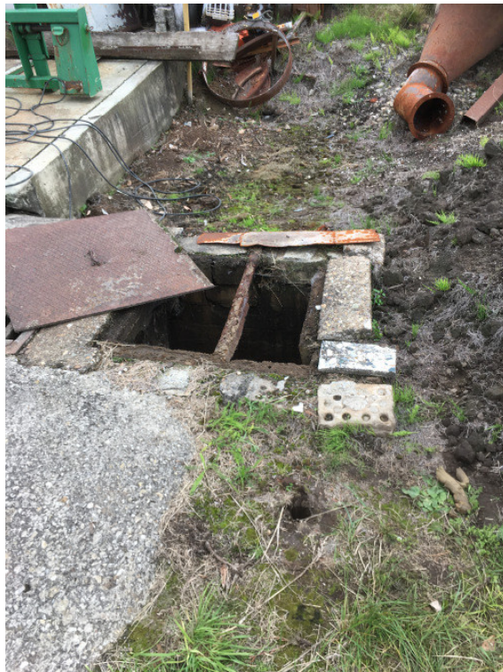
Foto: Sickerschacht im Hof, Sondierung RKS 2
