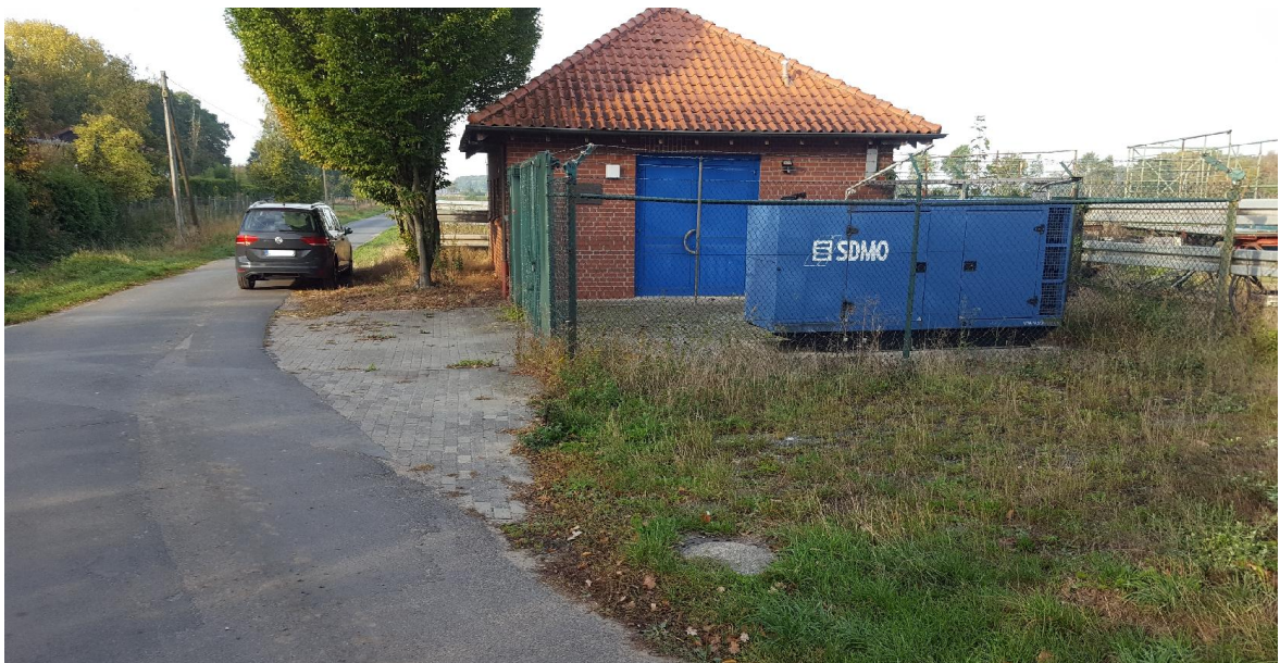
Abbildung 1: Bestehendes Schmutzwasserpumpwerk am Lönsweg in Oelde-Lette
