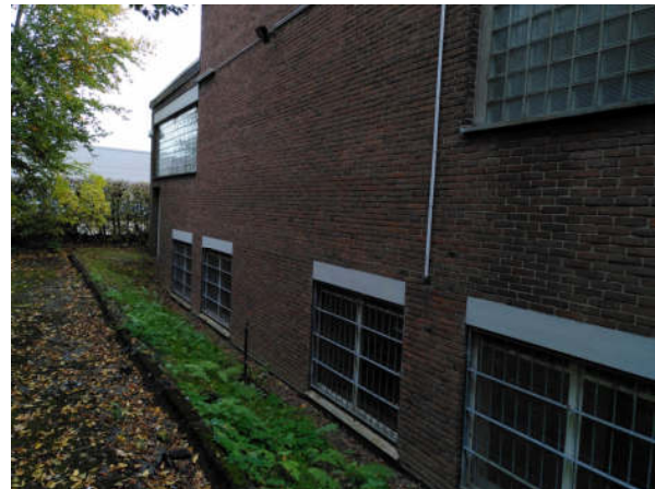
Foto 6: Lastenaufzug / Maschinenraum (außen)
