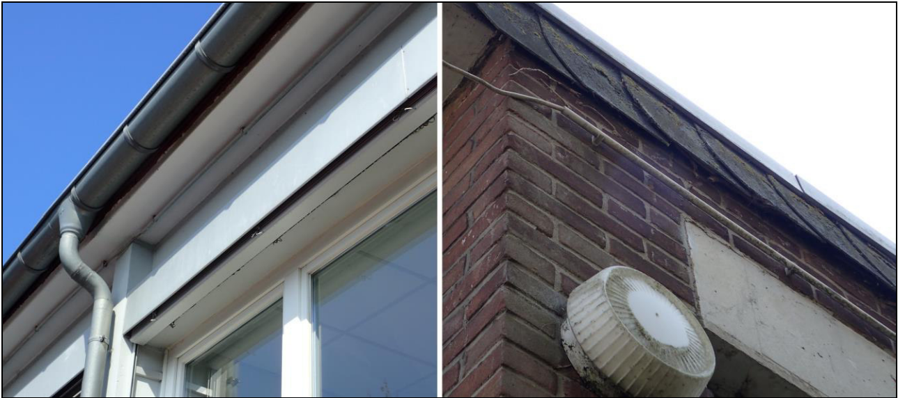
Abb. 5: Potenzielle Quartiere am Firmengebäude (Auswahl)
