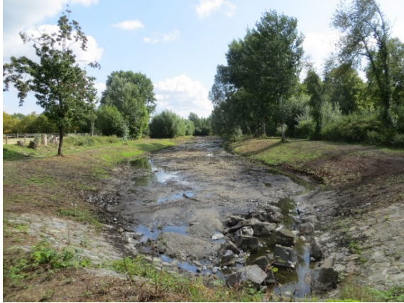
Südlich angrenzendes Regenrückhaltebecken
