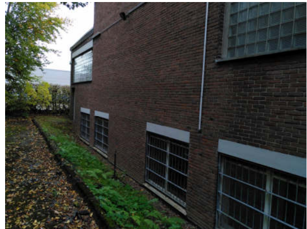
Foto 6: Lastenaufzug / Maschinenraum (außen)
