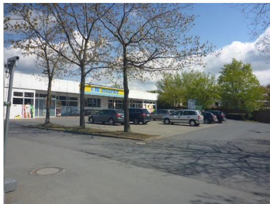
Abb. 11 Bäume im Bereich des Parkplatzes.
