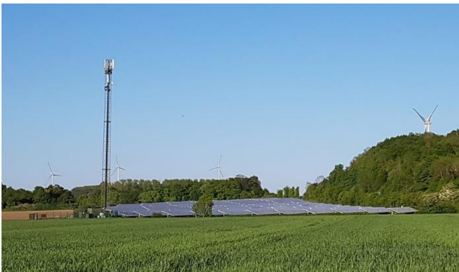
Abb. 5: Der Blick auf die vorhandene PV-Anlage vermittelt einen guten Eindruck, wie auch der Erweiterungsbereich links davon aussehen wird.
