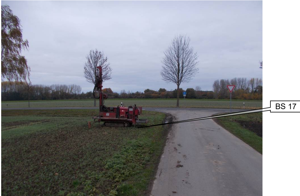
Foto 16: Blickrichtung ~N; Bereich der BS 17 (Markierung)
