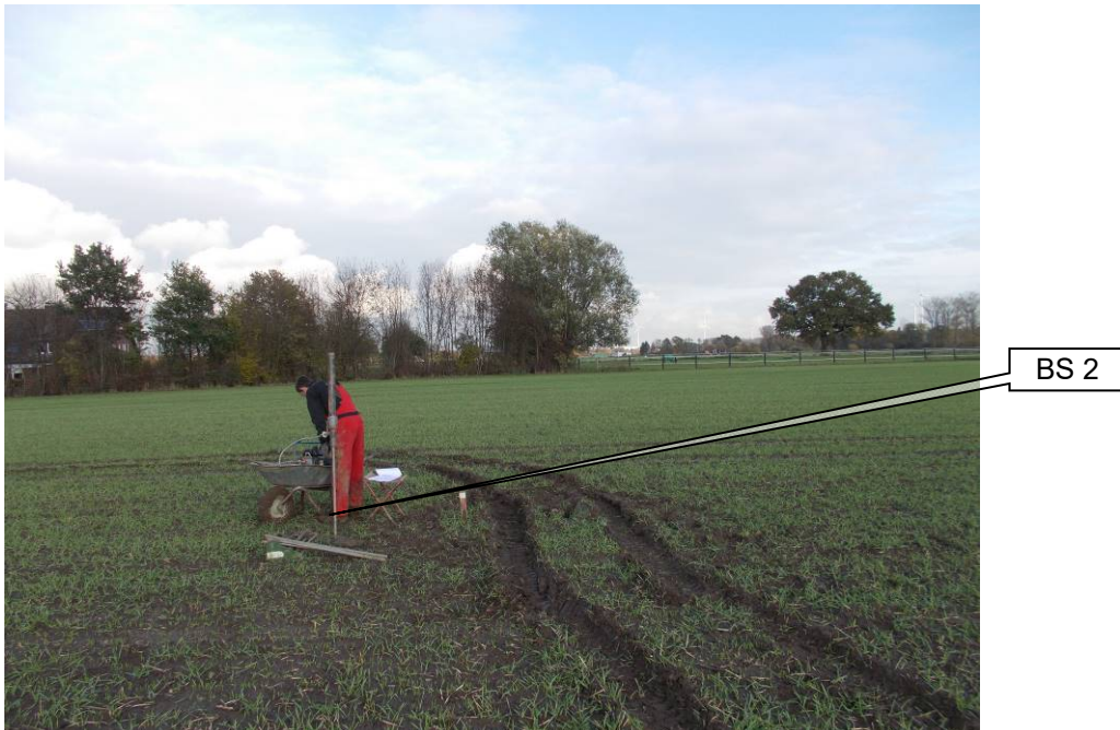
Foto 4: Blickrichtung ~ONO; Bereich der BS 2 (Markierung)
