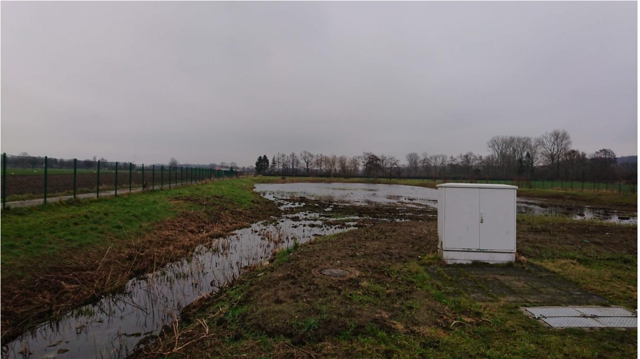
Planbereich, bestehendes Regenrückhaltebecken
