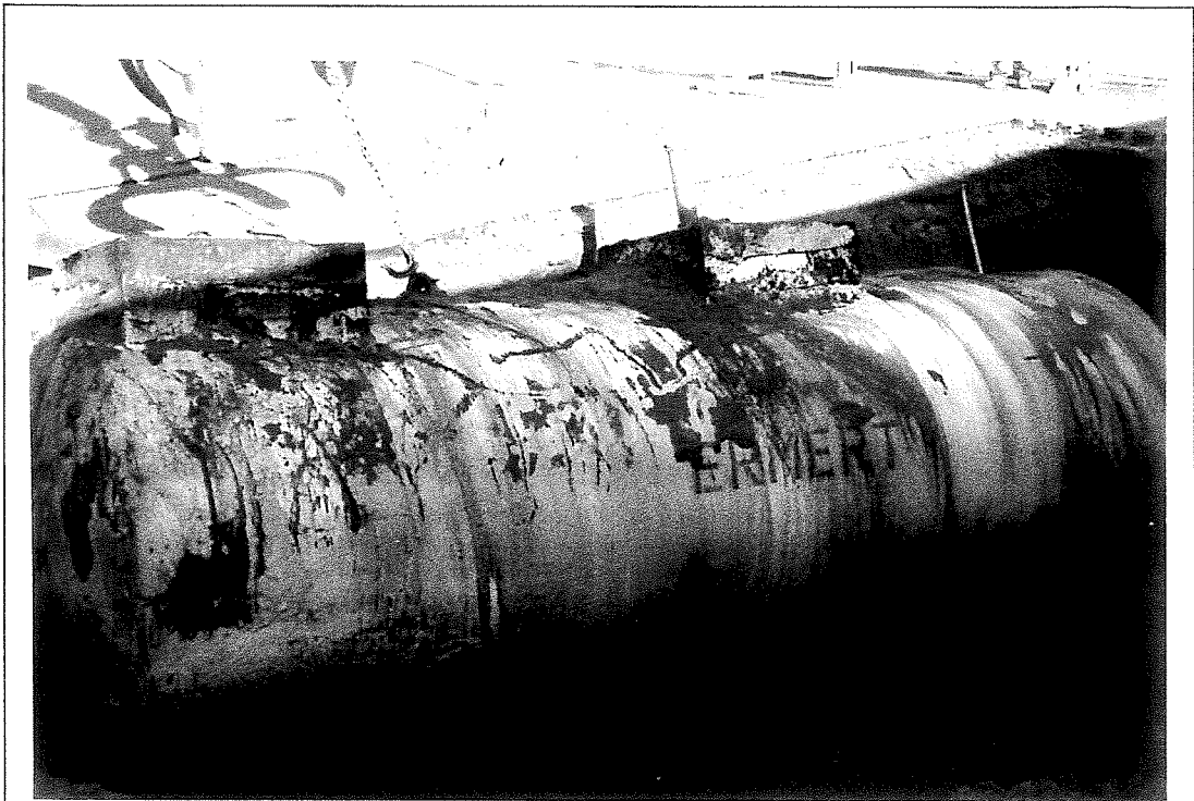
Foto 4: Ausgebauter Zweikamer-Tankbehälter (2 x 10.000 l)
