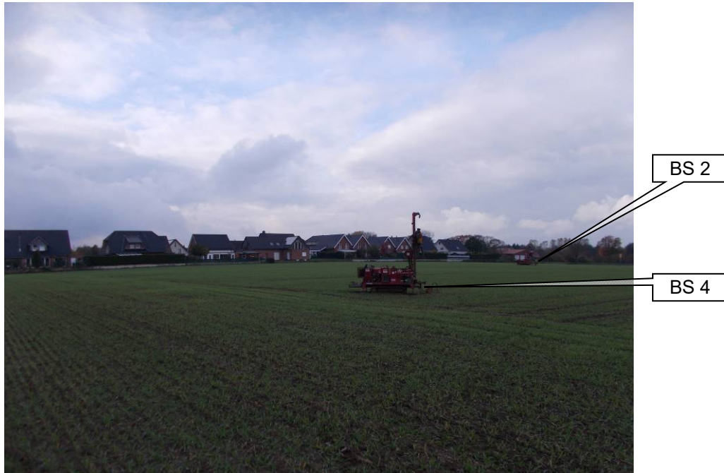
Foto 3: Blickrichtung ~NW; Bereich der BS 2 und BS 4 (Markierungen)
