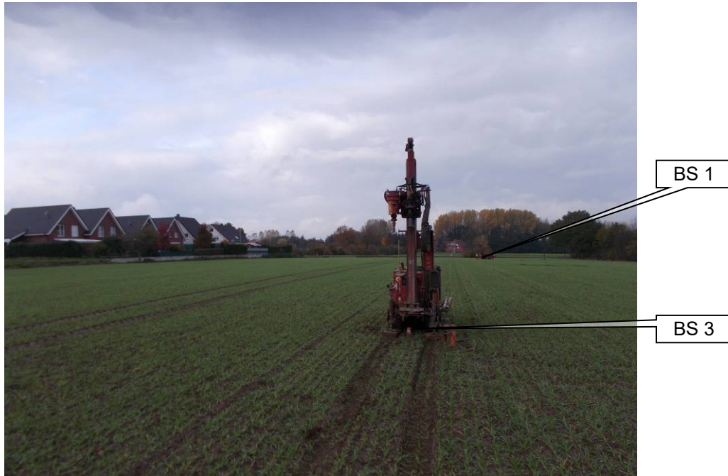
Foto 1: Blickrichtung ~NW; Bereich der BS 1 und BS 3 (Markierungen)
