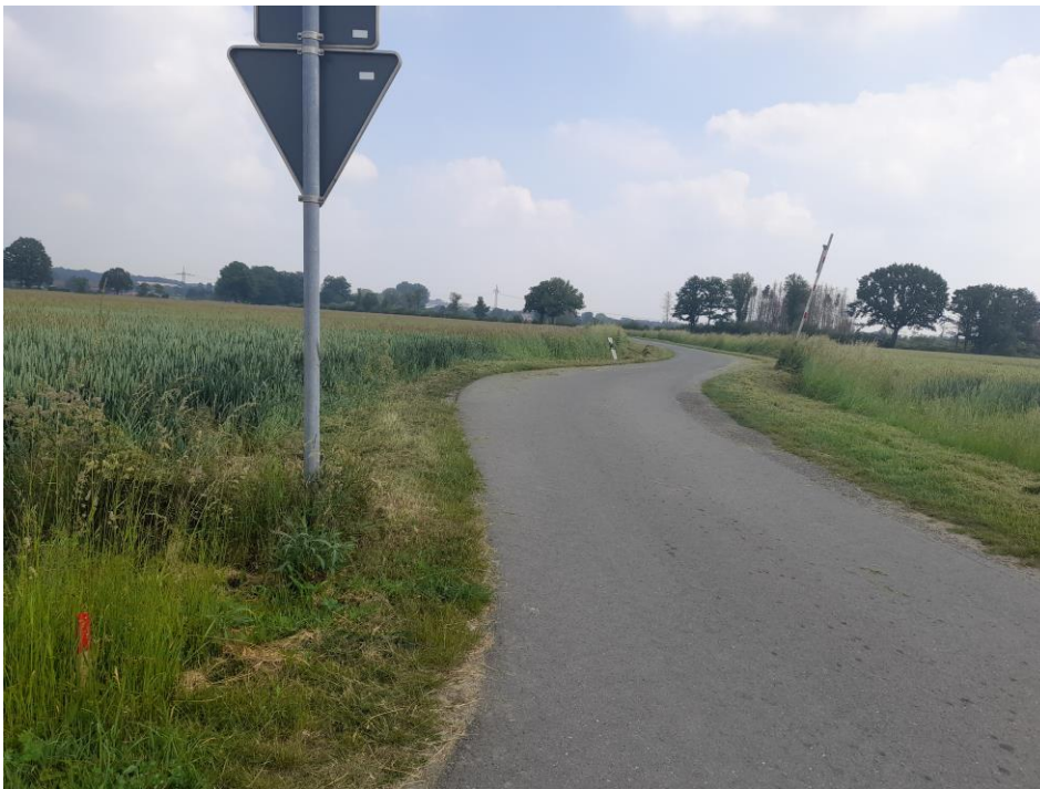
Abb. 9: Zufahrt zum „Westrickweg“ im südöstlichen Plangebiet (Blickrichtung Norden).
