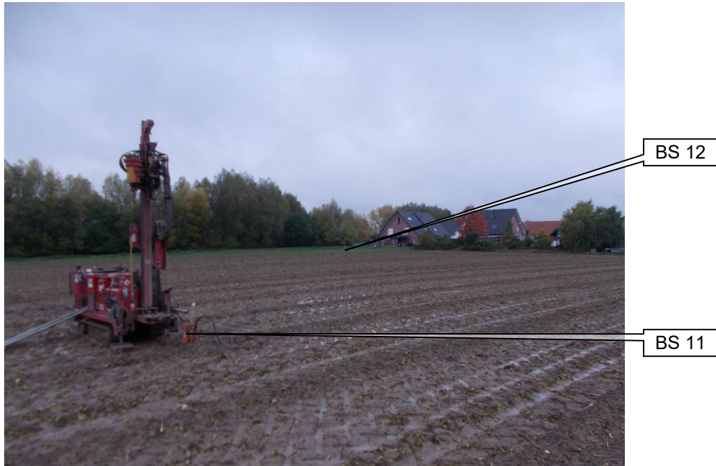
Foto 11: Blickrichtung ~SW; Bereich der BS 11 und BS 12 (Markierungen)
