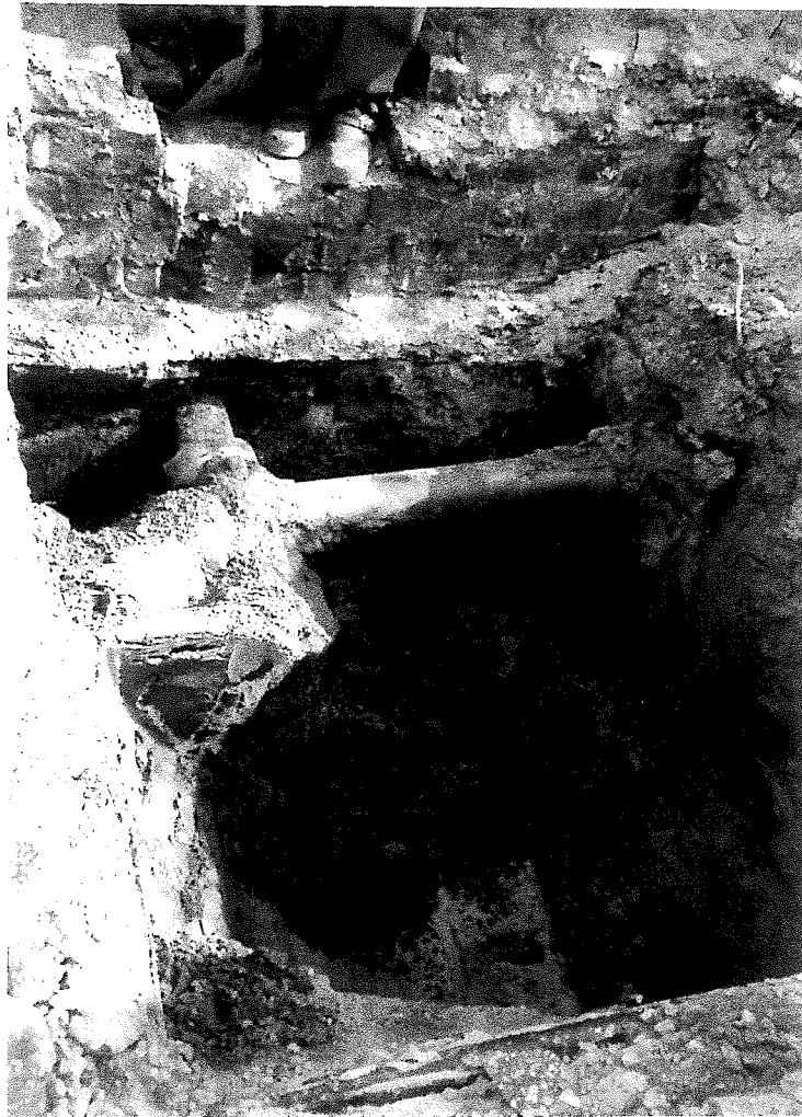
Foto 2: Aushubgrube vor der Waschhalle
