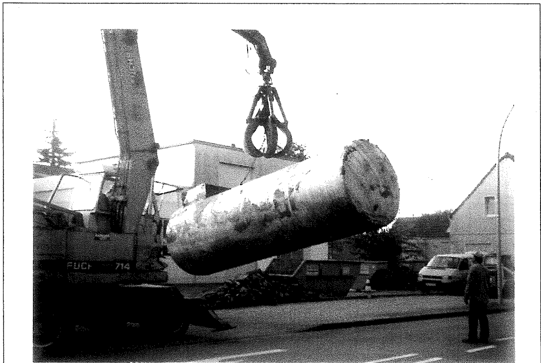
Foto 3: Ausgebauter 20.000 l Tankbehälter
