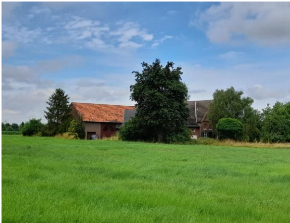
Abb. 18: Hofstelle im zentral gelegenen Geltungsbereich (Blickrichtung Nordosten).
