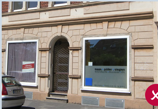
großformatige Schaufenster fügen sich nicht in Fassadengestaltung ein
