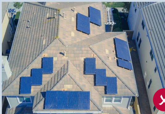
keine Zusammenfassung von Kollektoren erzeugt unruhige Dachlandschaft
