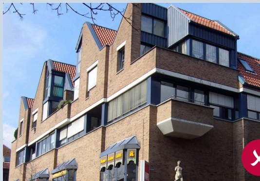
dominierende Dachaufbauten beeinflussen die Dachlandschaft negativ
