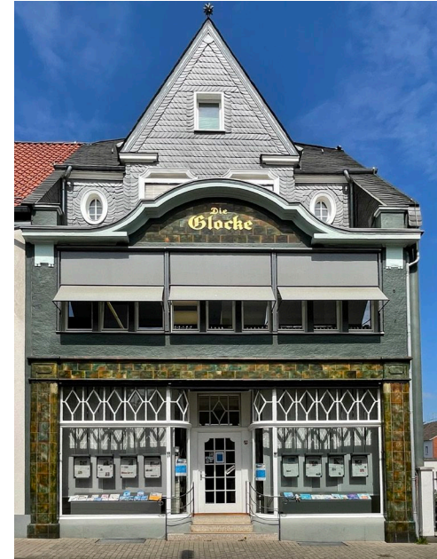
Beispielhafte Fassade eines historischen Gebäudes
