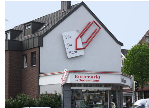
Beispiel einer Gebäudeabschlusswand mit mangelhafter Gestaltung
