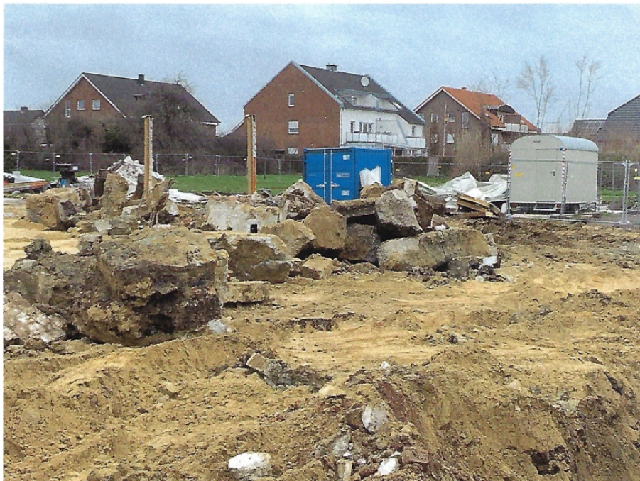
Foto 18: Ansicht der ausgehobenen Fundamente vor der weiteren Zerkleinerung.
