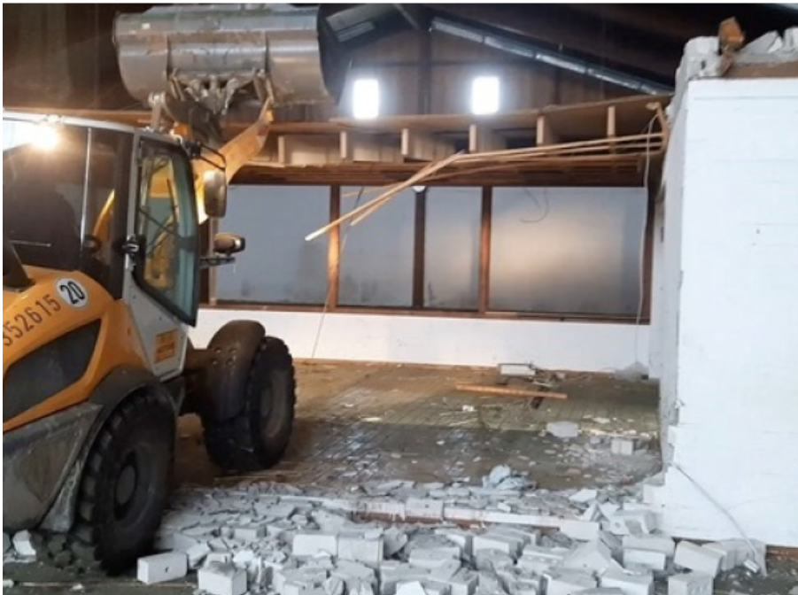
Foto 8: Ansicht auf den Rückbau der Zwischendecke mittels Radlader.
