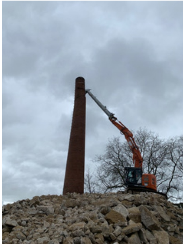
Foto 13: Blick auf den Rückbau des Schornsteins.
