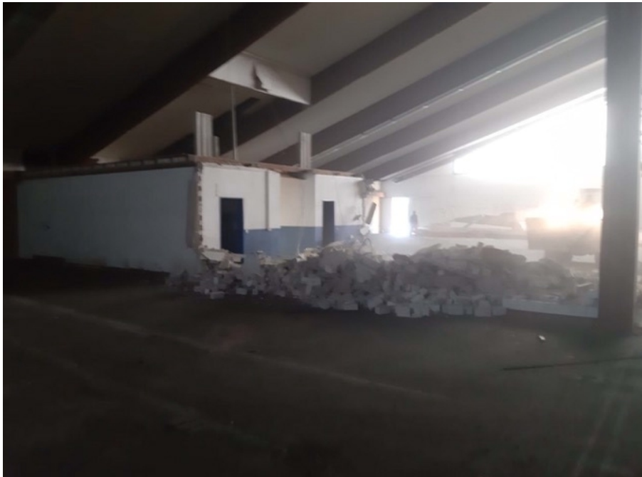
Foto 3: Blick auf den Rückbau der Einbauten.
