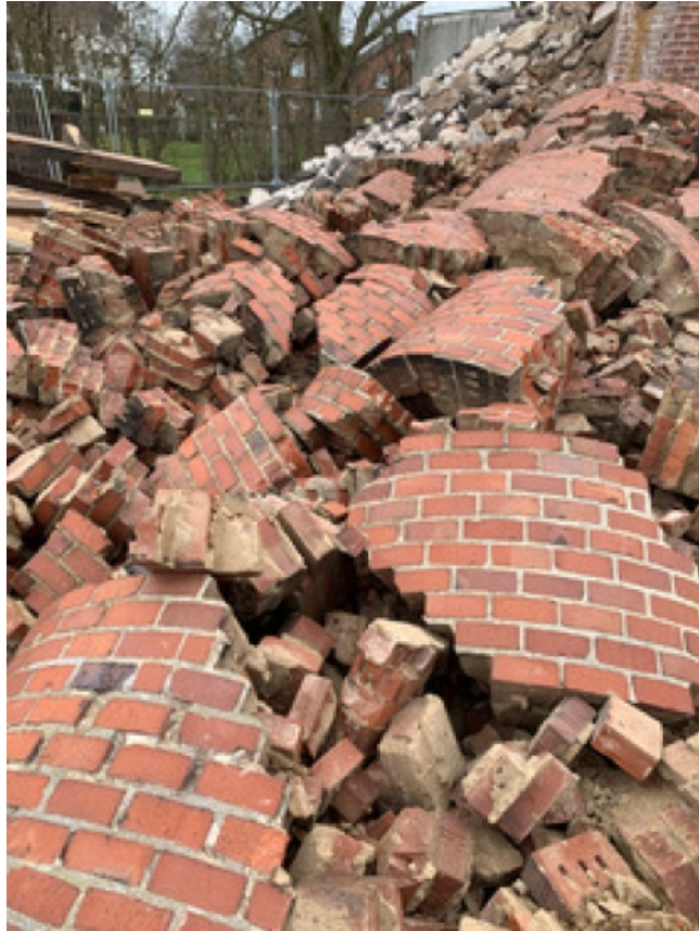
Foto 15: Ansicht auf den umgelegten Schornstein - keine Fremdbestandteile ersichtlich.
