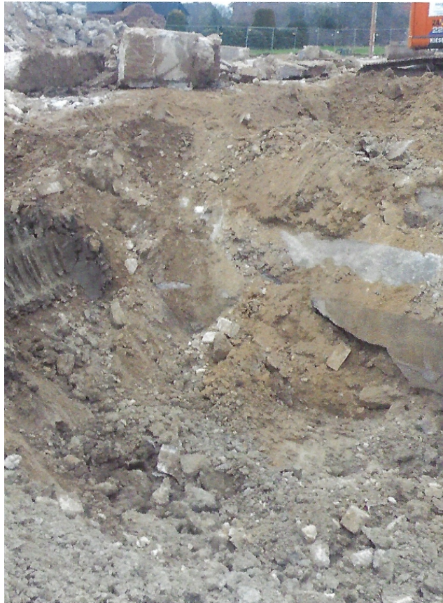
Foto 17: Blick auf einen Teil des Rundbeckens.
