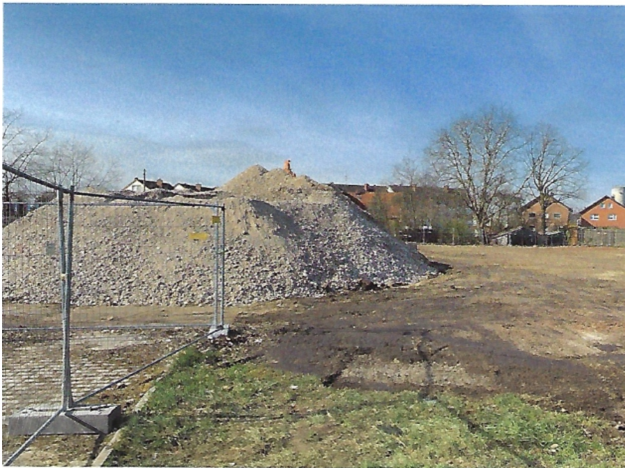
Foto 24: Ansicht auf das erzeugte RCL-Material bei Bauabnahme, Blickrichtung: Süd-West.
