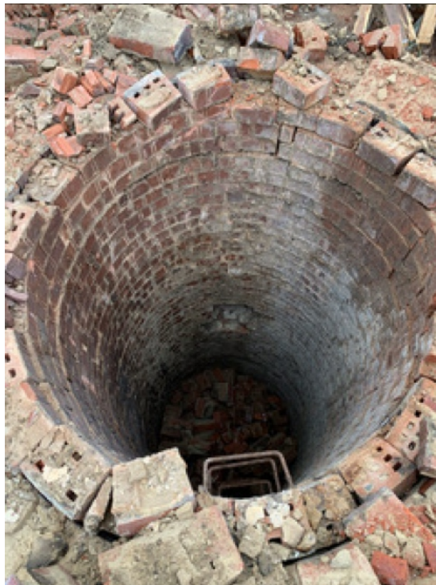
Foto 14: Blick in den ehem. - Schornstein - keine Verkrustungen vorhanden.
