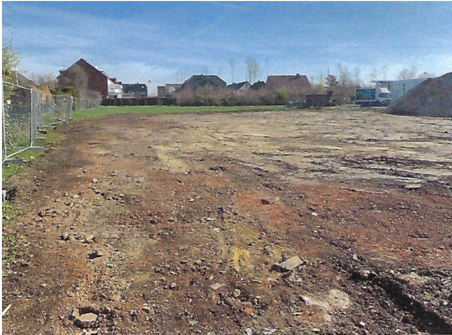
Foto 23: Ansicht auf das Grundstück nach den Rückbauarbeiten, Blickrichtung: Nord-Ost.
