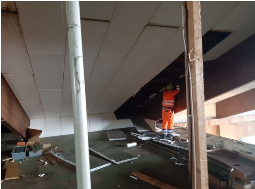
Foto 2: Ansicht auf die weiteren Entkernungsarbeiten: Ausbau von Dachisolierungen.
