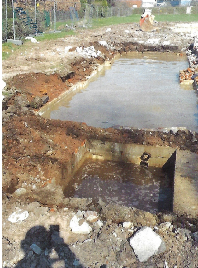
Foto 19: Ansicht auf mit Waasser befüllter, rechteckiger Becken vor dem Leerpumpen.
