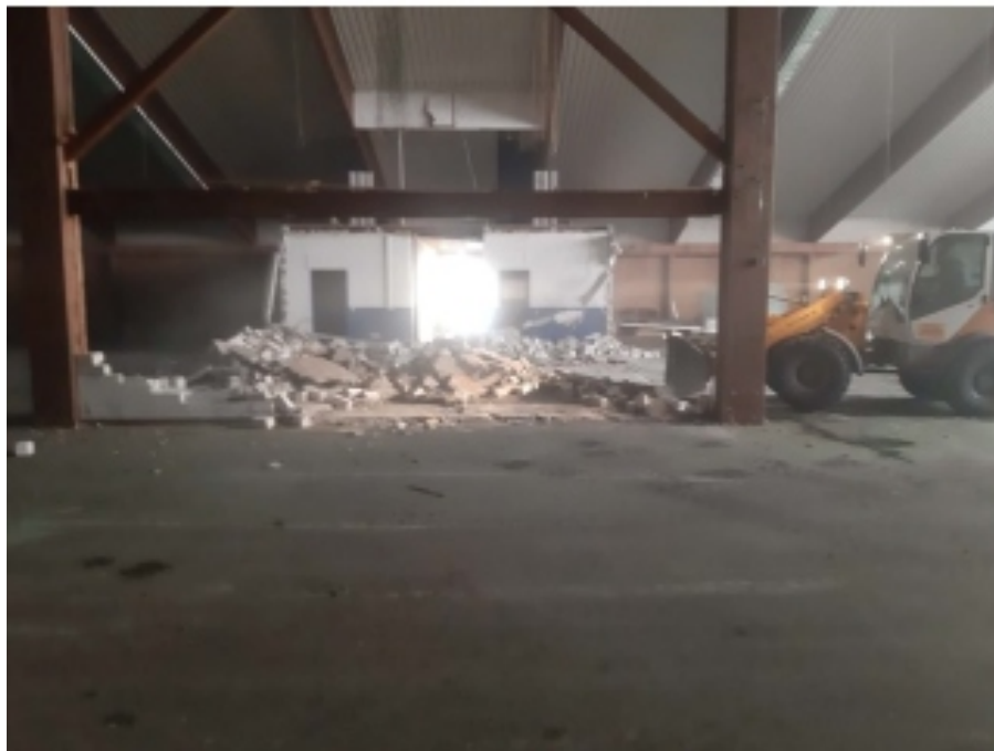
Foto 4: Weiterer Blick in die ehemalige Halle - Entkernung der innenliegenden Bauteile.
