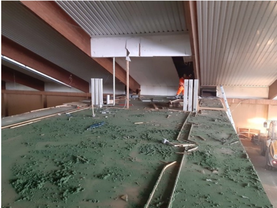
Foto 1: Ansicht auf die Entkernungsarbeiten - Rückbau der Dachlamellen, Tartanbahnen und weitere Bodenbeläge bereits ausgebaut.
