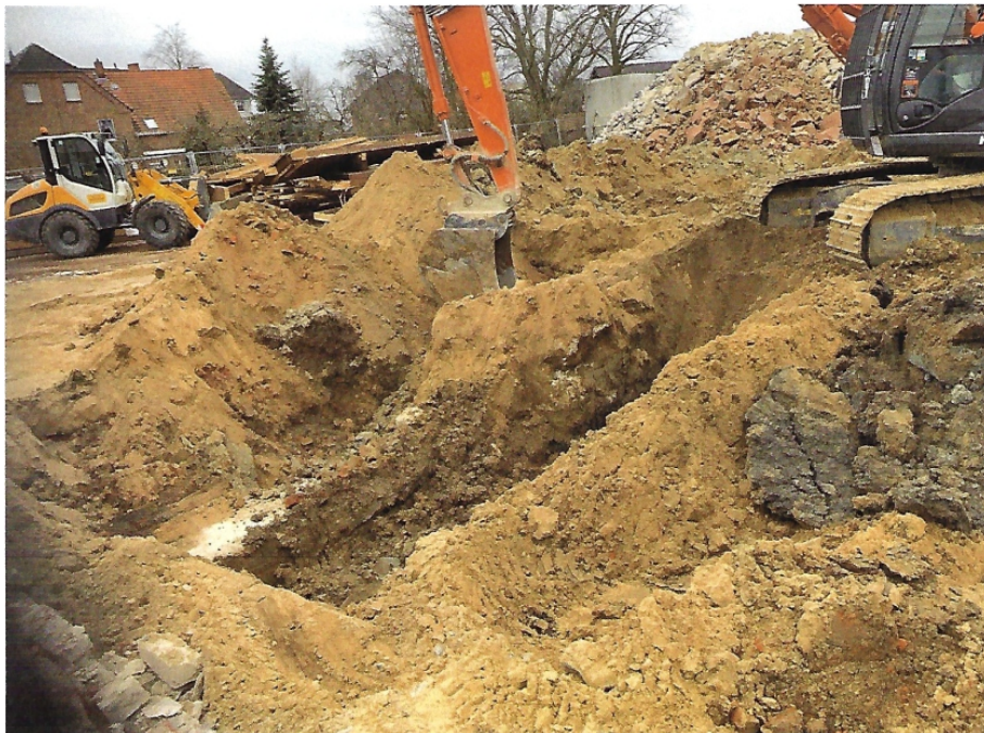
Foto 16: Ansicht auf das Freilegen des runden Beckens.
