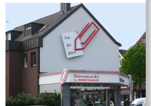
Beispiel einer Gebäudeabschlusswand mit mangelhafter Gestaltung
