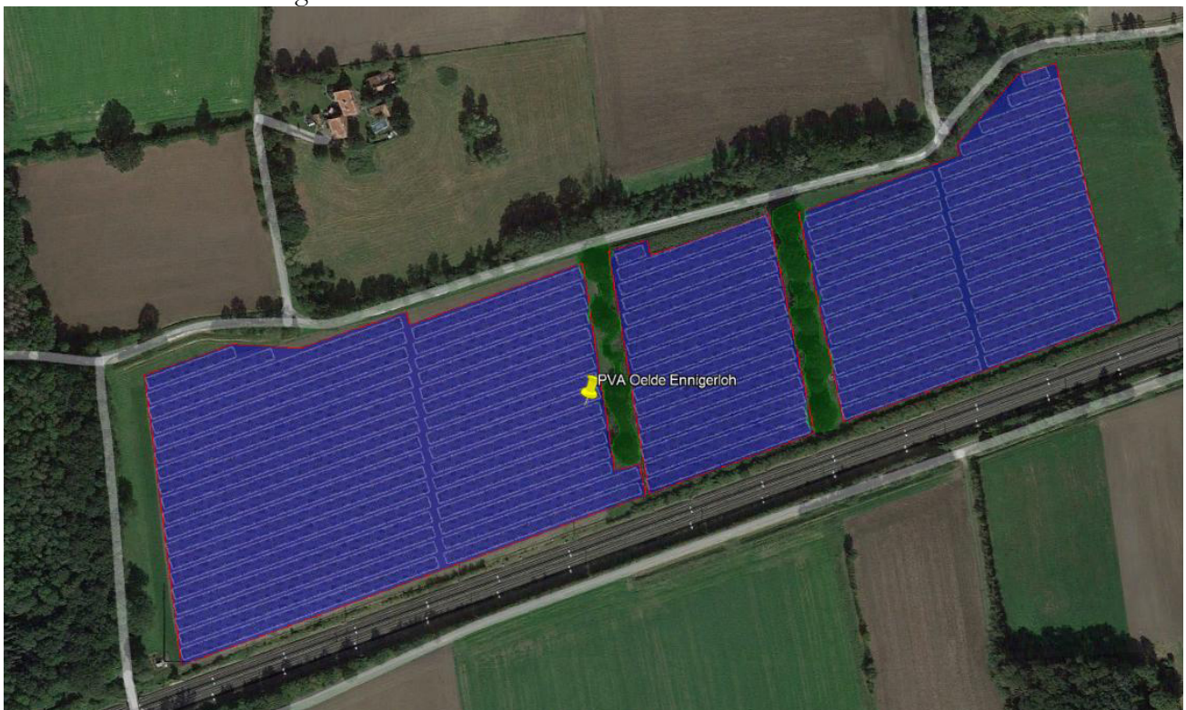
Bild 2.1.3: Detailansicht der PV Fläche (Quelle: Google Earth/SolPEG)
