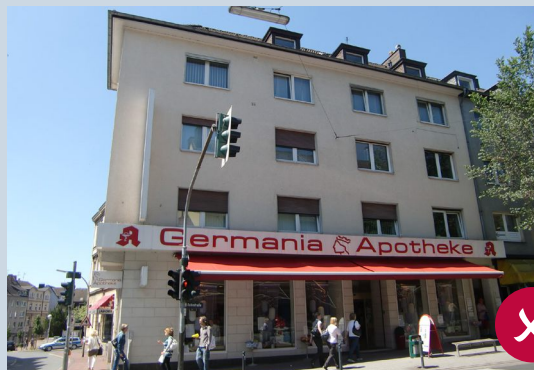
flächiger Schriftzug dominiert Fassade
