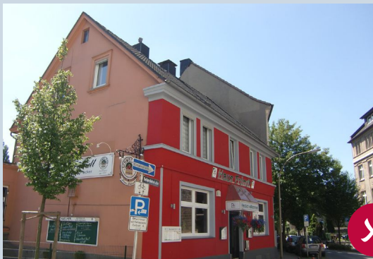
Straßenseitige Fassade fügt sich nicht in das Gebäude ein
