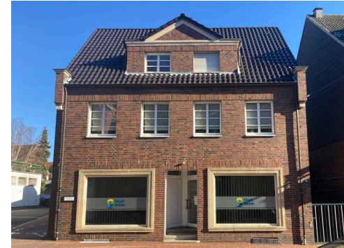
Beispielhafte Gebäude mit kleinteiligen Dachaufbauten
