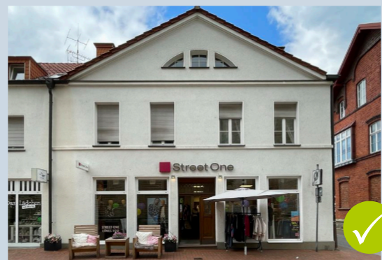
Schaufenster sind in das Gesamtbild der Fassade integriert
