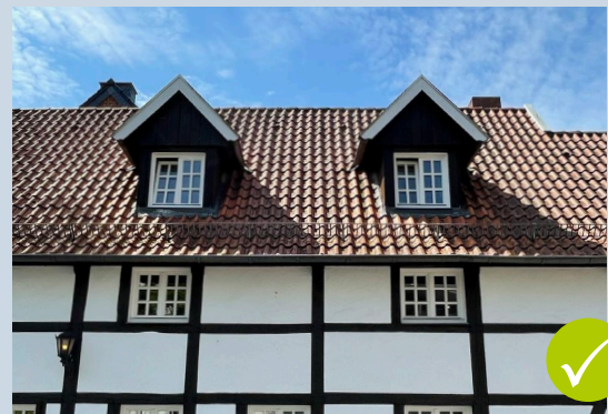
Dachaufbauten sind in Gesamtbild integriert und in Fassadengliederung eingeordnet
