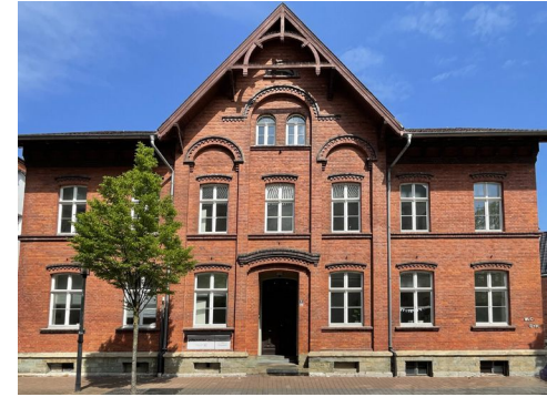
Beispielhafte Anordnung entlang der Senkrechten und Erhalt baustiltypischer Formen
