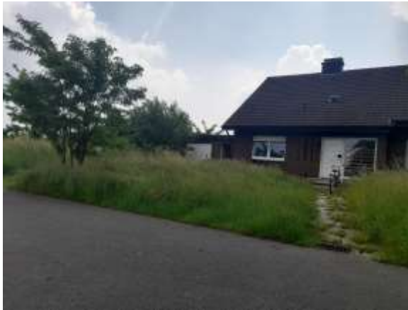
Abb. 22: Wohnhaus im zentralen Plangebiet (Blickrichtung Südosten).
