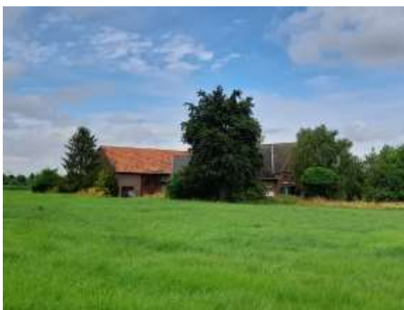
Abb. 18: Hofstelle im zentral gelegenen Geltungsbereich (Blickrichtung Nordosten).
