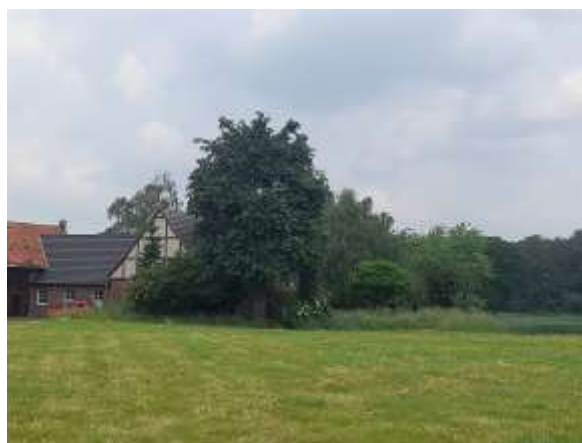
Abb. 19: Zufahrtsweg zur Hofstelle im nördlichen Geltungsbereich (Blickrichtung Süden).
