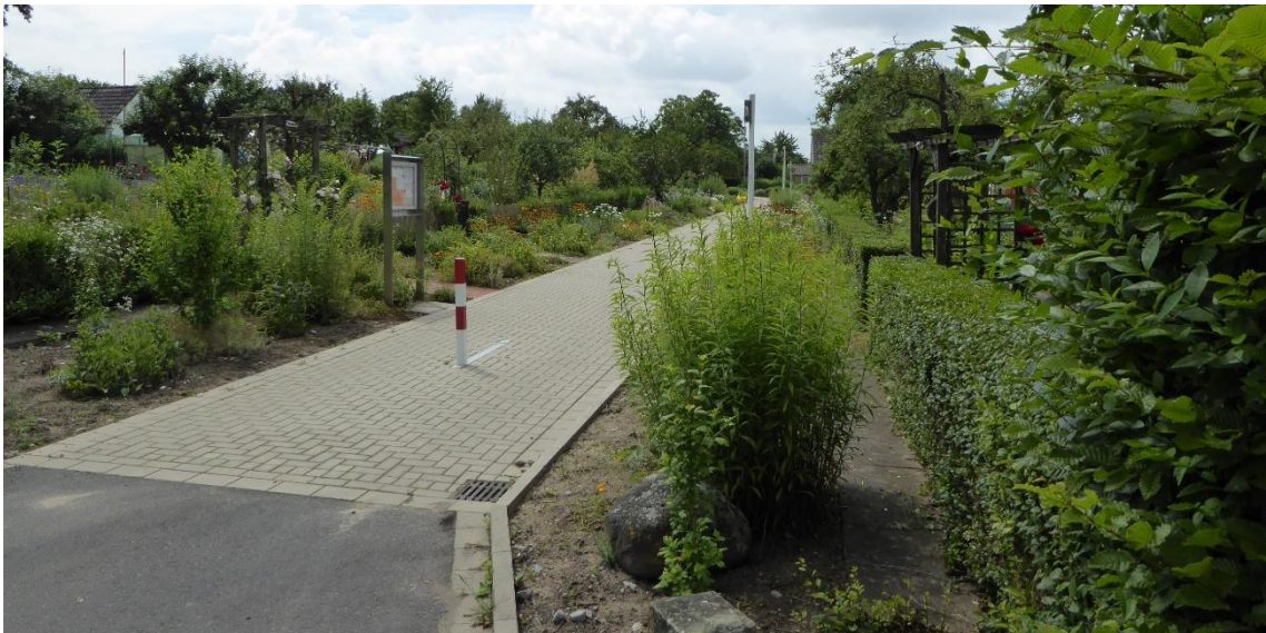
A - V: Eingang zur Kleingartenanlage am Kurenholtweg
