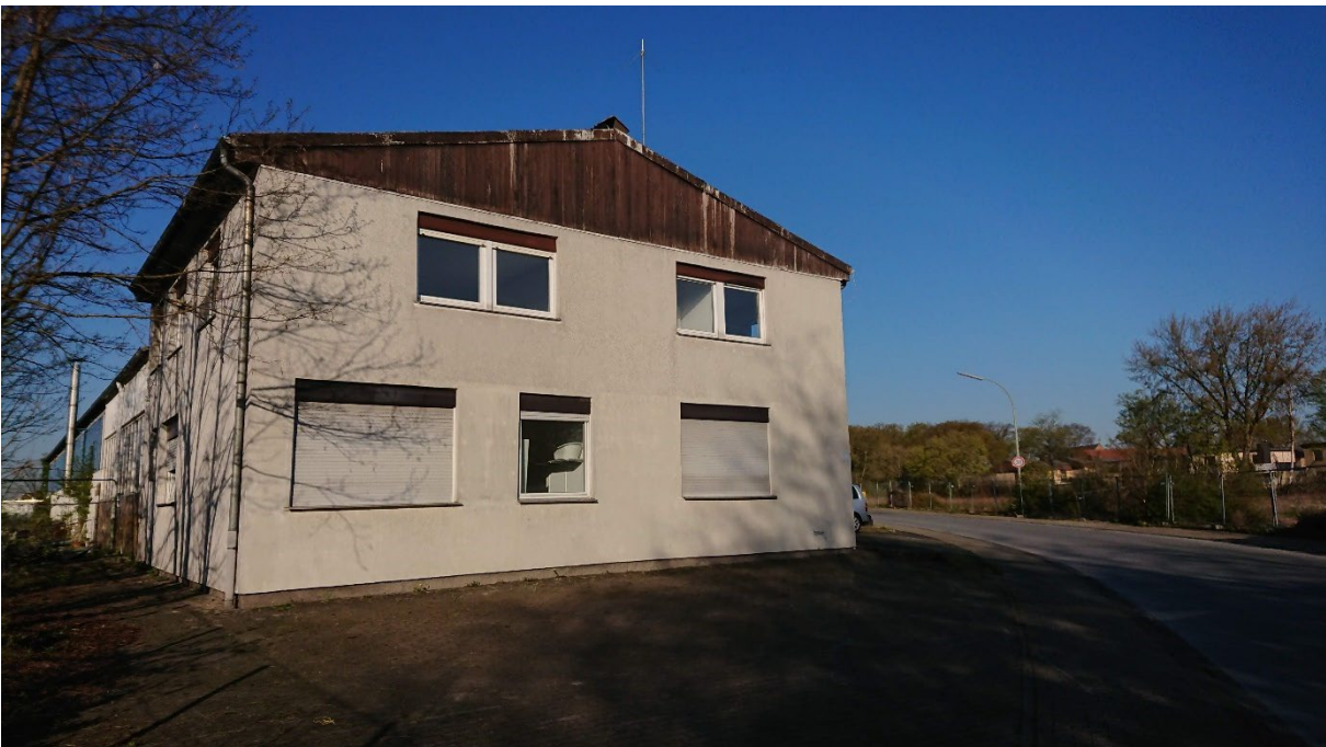
Foto 6: Gebäude vom Busunternehmen (Blick nach Westen)
