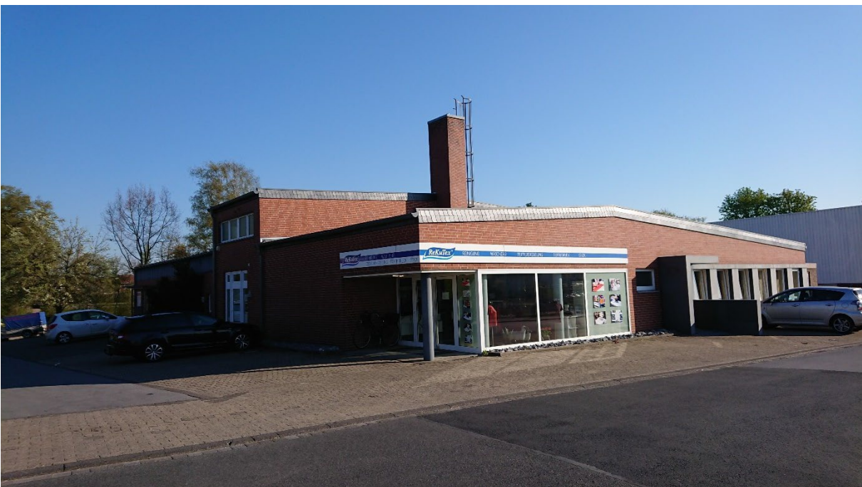
Foto 10: nordwestliche Gebäude (Blick nach Nordwesten)
