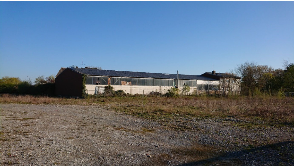
Foto 5: Rückseite der Gebäude vom Busunternehmen (Blick nach Nordosten)
