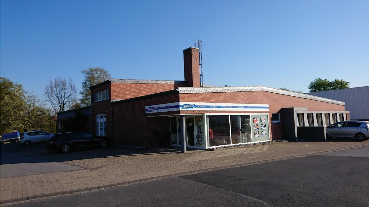
Foto 11: nordwestliche Gebäude (Blick nach Nordwesten)
