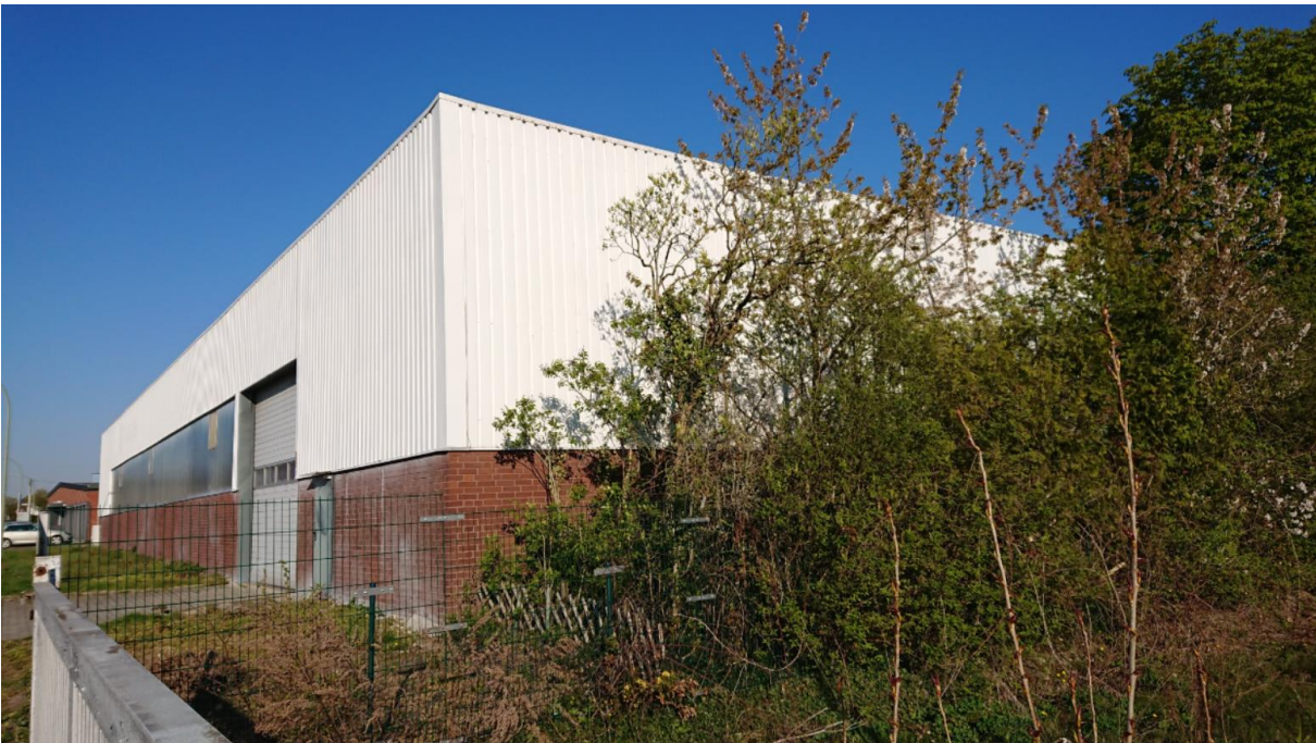
Foto 12: nordwestliche Gewerbehalle (Stahlbau) (Blick nach Nordwesten)
