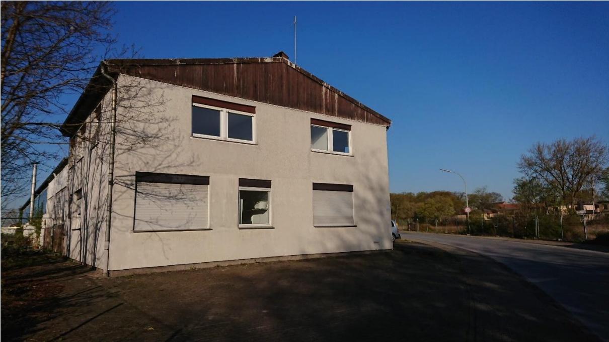
Foto 7: Gebäude vom Busunternehmen (Blick nach Westen, 2021)
