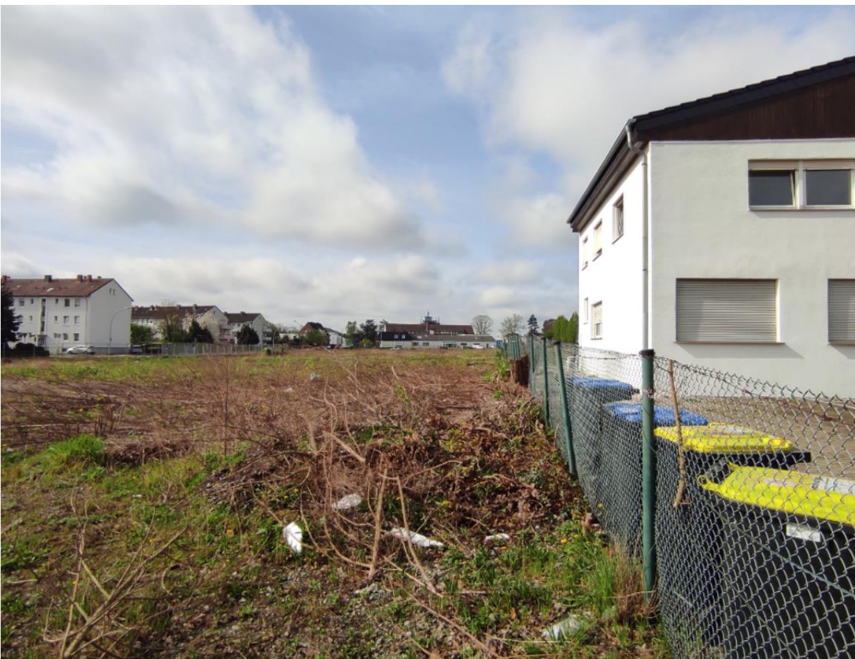
Foto 8: Gebäude vom Busunternehmen (Blick nach Westen, 2024) dahinterliegende Halle abgebrochen
