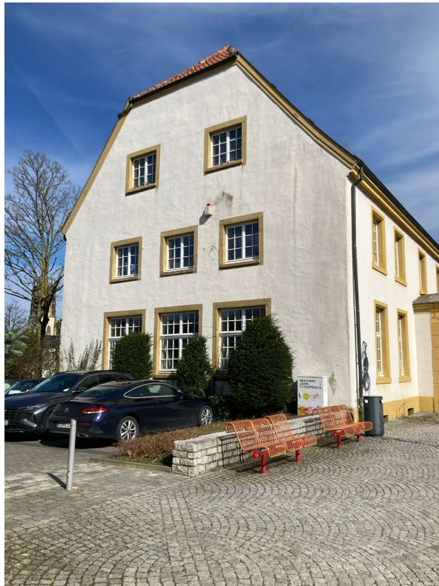
Blick auf rückseitige Giebel- fassade: verstellt durch PKWs und unpassende Begrünung
