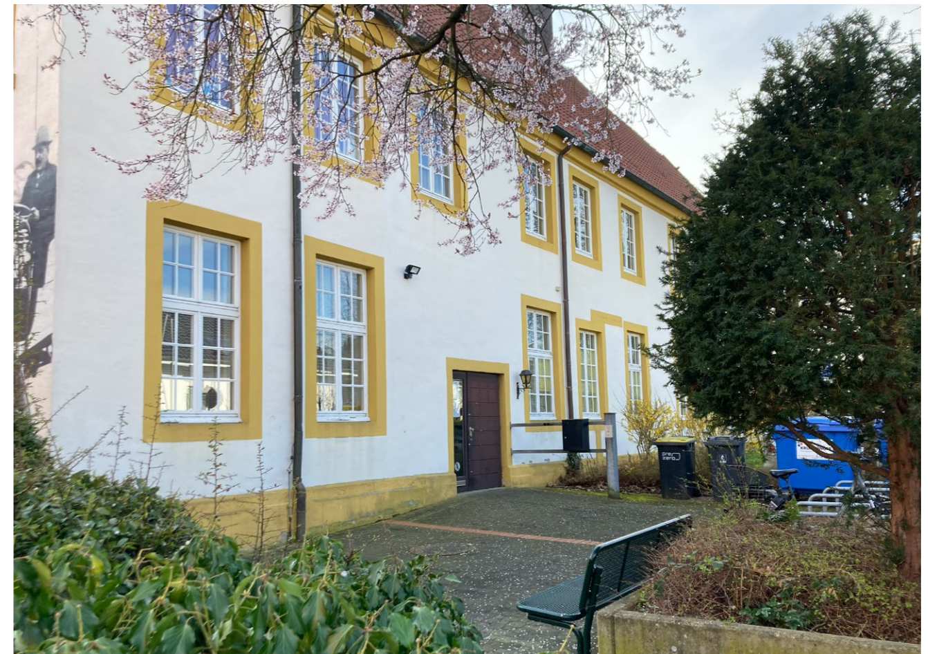
Blick auf barrierefreien Nebeneingang: Für Personen ohne Ortskenntnis unauffindbar, lan- ge Wege, Zugang direkt neben Mülltonnen
