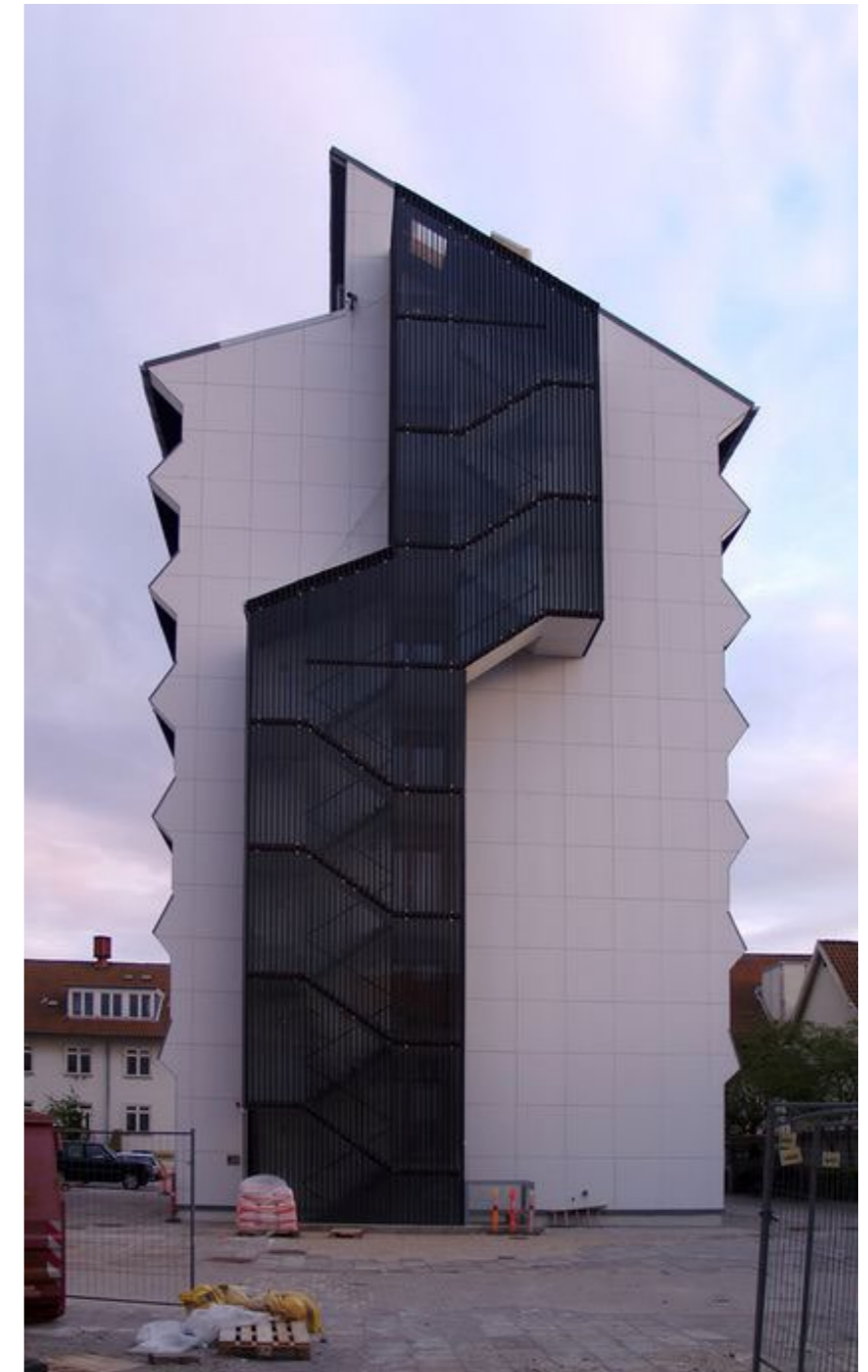
Hammershøj Care Centre, Dänemark, von Jørn Utzon
