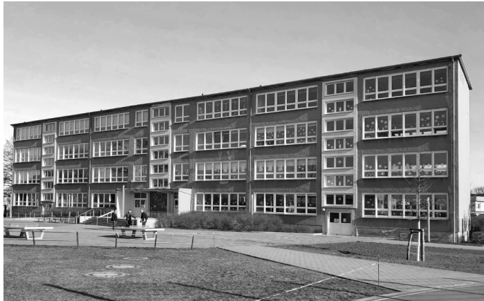
DDR- Typenschulbauhaus „Typ Erfurt“ vor der Sanierung
