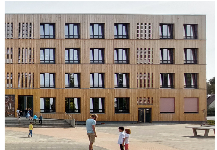
Einheitliche Hülle aus Lärchenholz
