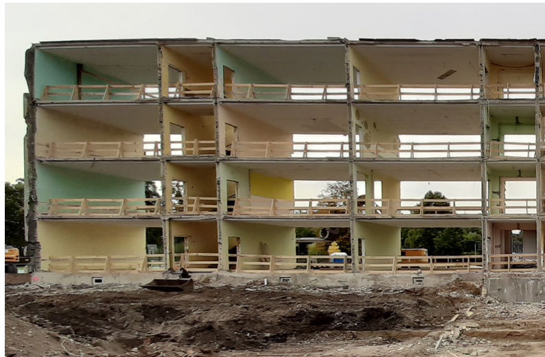
Freigelegtes Stahlbeton-Tragskelett
